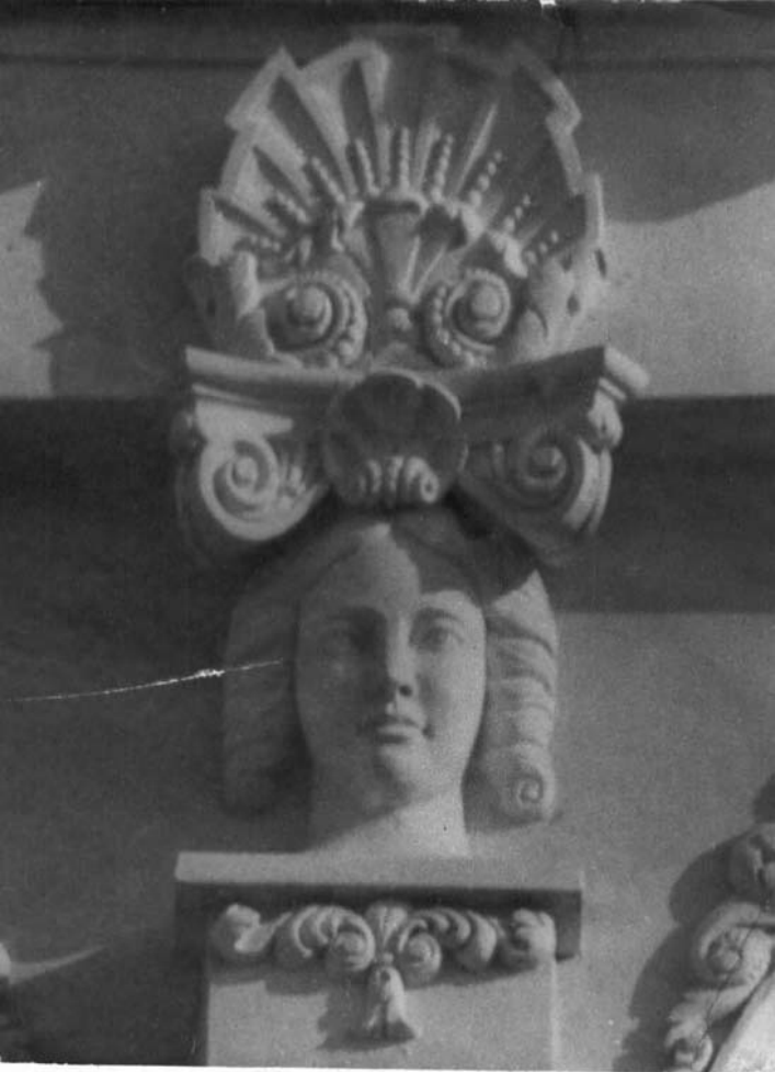
Верхнее завершение пилястр
