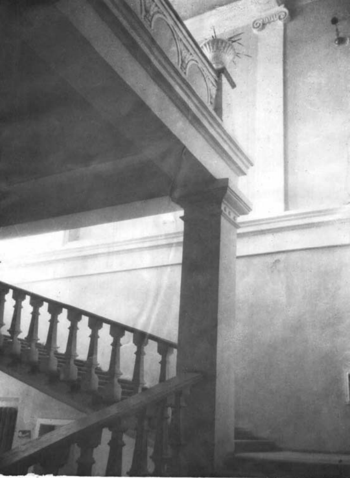
фрагмент главной лестницы
