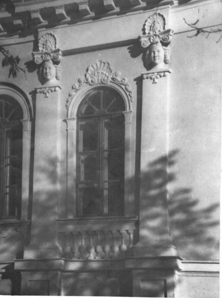
Фрагмент главного фасада
