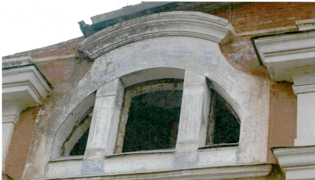
6. Трехчастное окно в третьем уровне повышенной северной части здания
