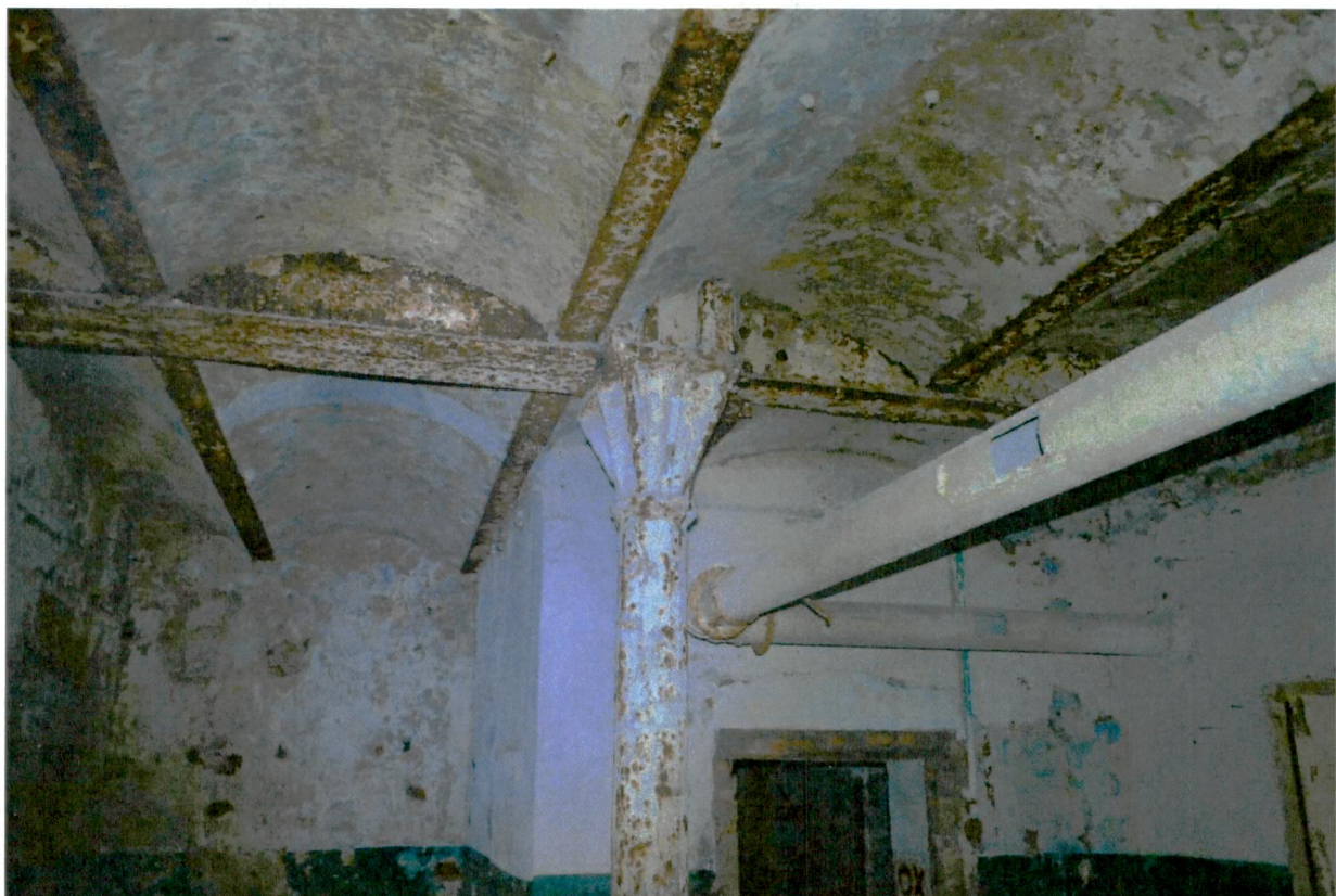
10. Чугунная колонна, система металлических балок и сводов Монье в перекрытии
