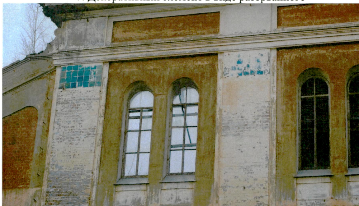
8. Столярные заполнения центральной части юго-восточного фасада
