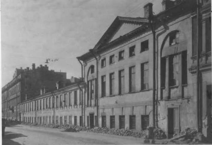
Фасад со стороны переулка.
