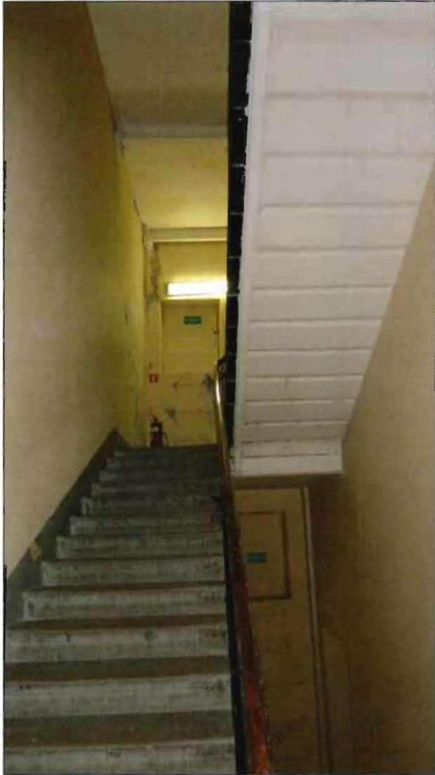
9. Лестница в восточной части здания.
