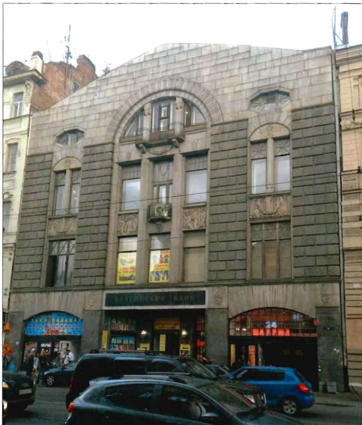
1. Общий вид с северо-запада.
