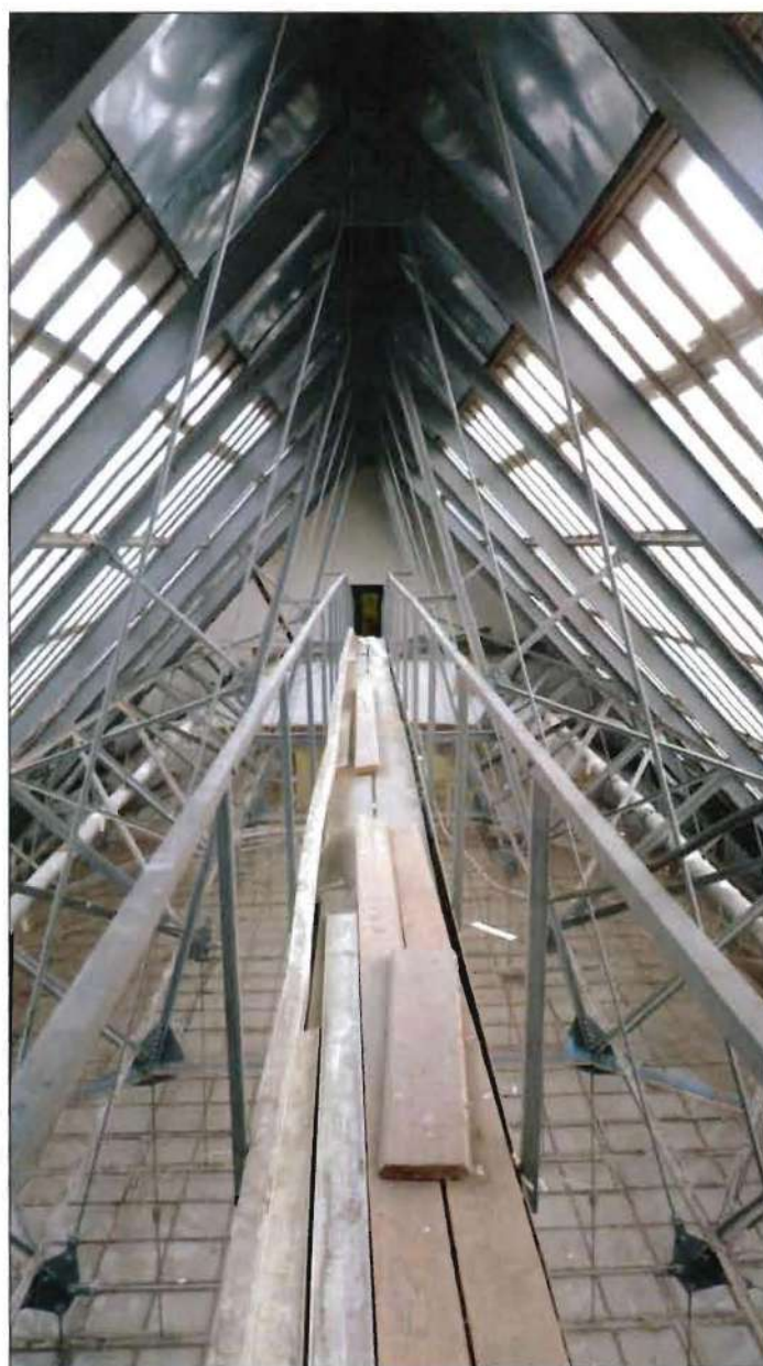
13. Конструкции светового фонаря.
