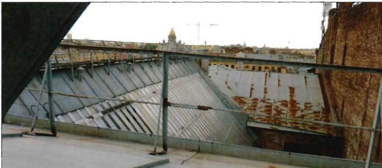
12. Кровля. Вид с юго-востока.
