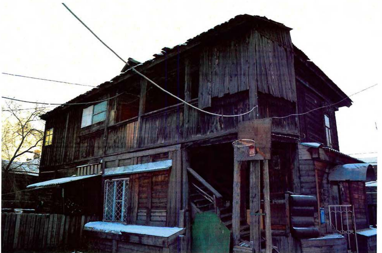
Фото 3. Общий вид с северо-запада.
