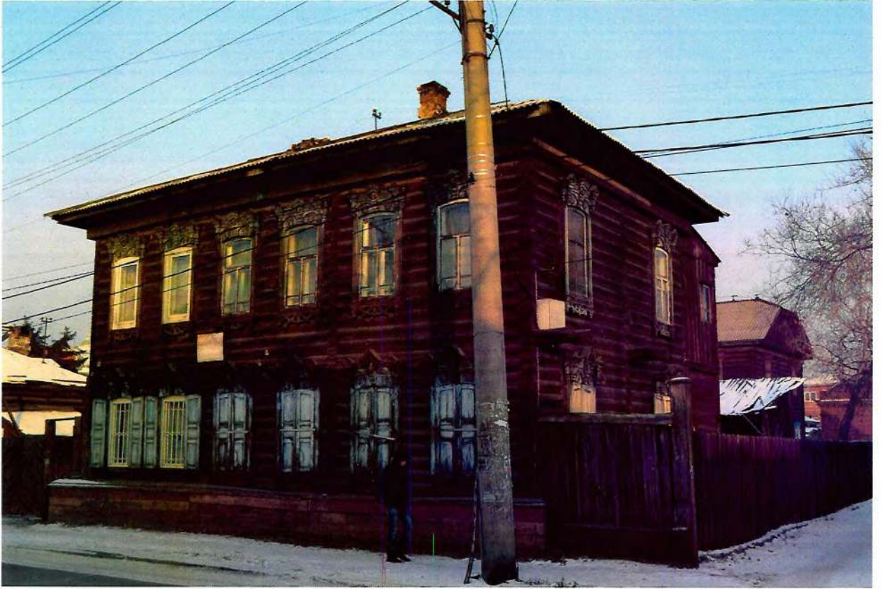
Фото 2. Общий вид с юго-востока.
