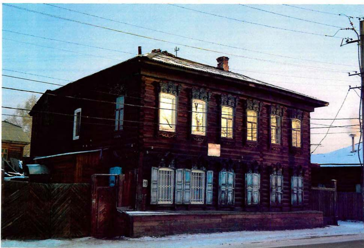
Фото 1. Общий вид с юго-запада.
