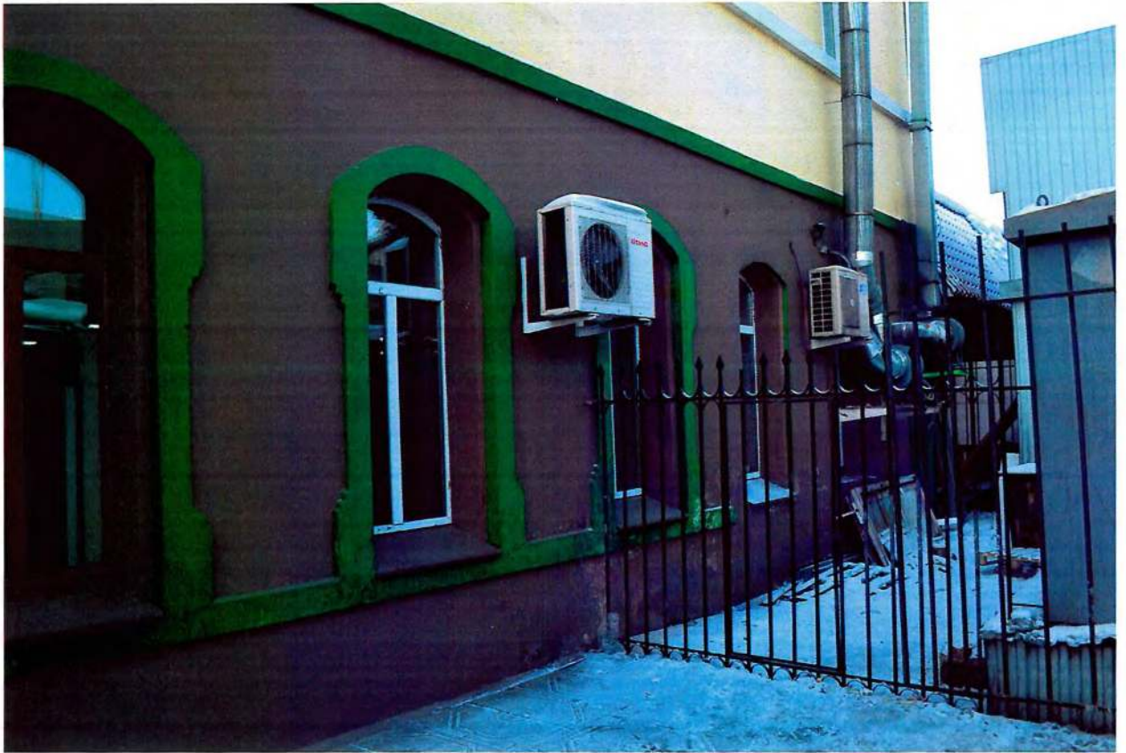
Фото 5. Восточный фасад. Фрагмент.
