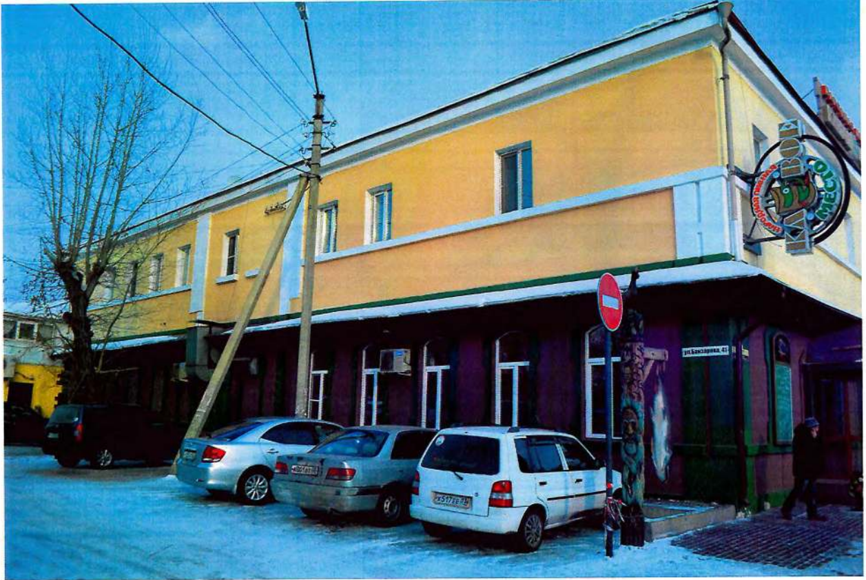
Фото 3. Общий вид западного фасада.
