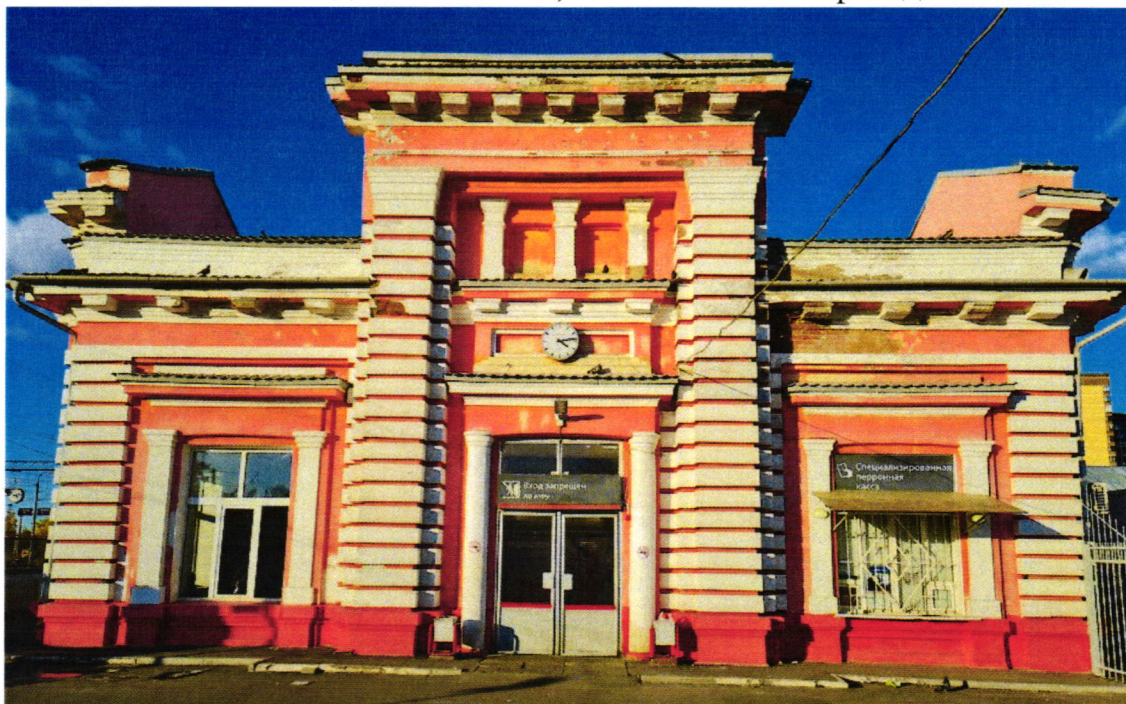
2. Здание вокзала, юго-западный фасад.
