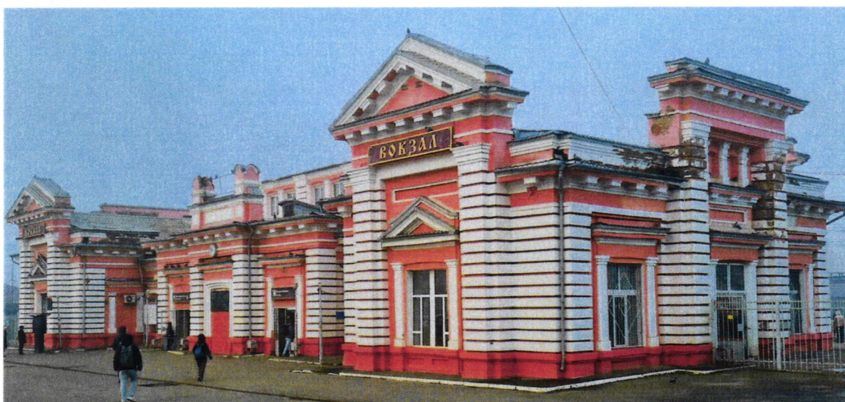
1. Здание вокзала, юго-восточный фасад.
