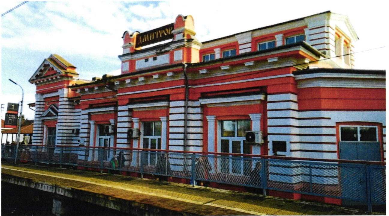
5. Здание вокзала, вид со стороны перрона.
