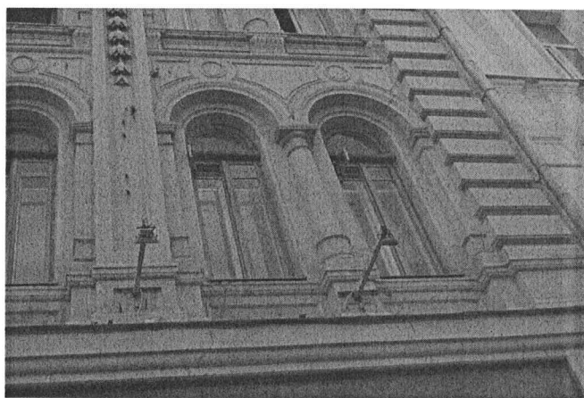
Декор оконных проёмов второго этажа Северо-восточный фасад лит. А
