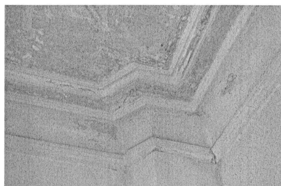
Потолочный и пристенный карниз помещения №15,16
