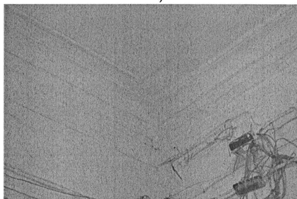
Потолочный и пристенный карниз помещения №13
