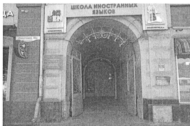
Проездная арка со стороны фасада по ул.Советской. Лит.А
