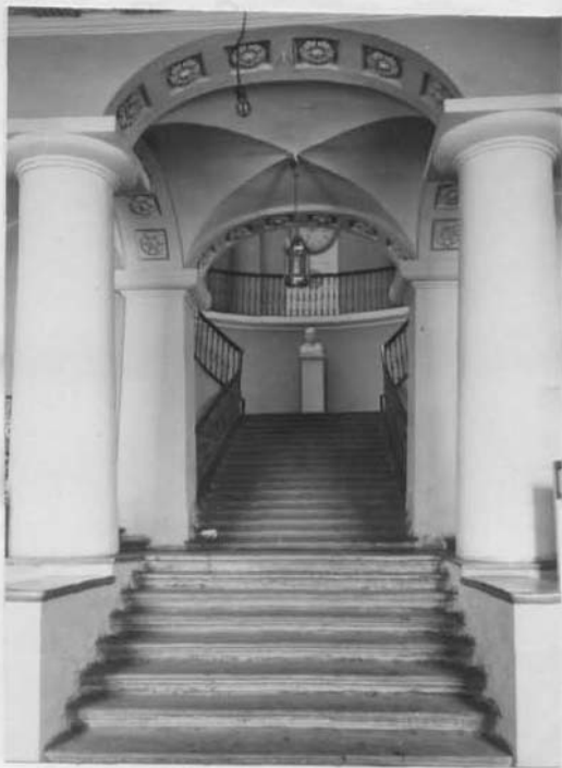
Вестибюль /1-й этаж/.
