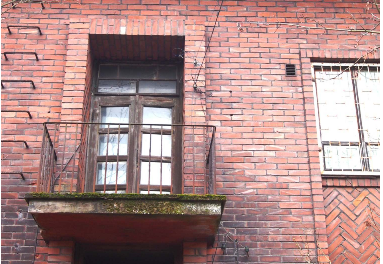
13. Балкон над южным входом восточного фасада.
