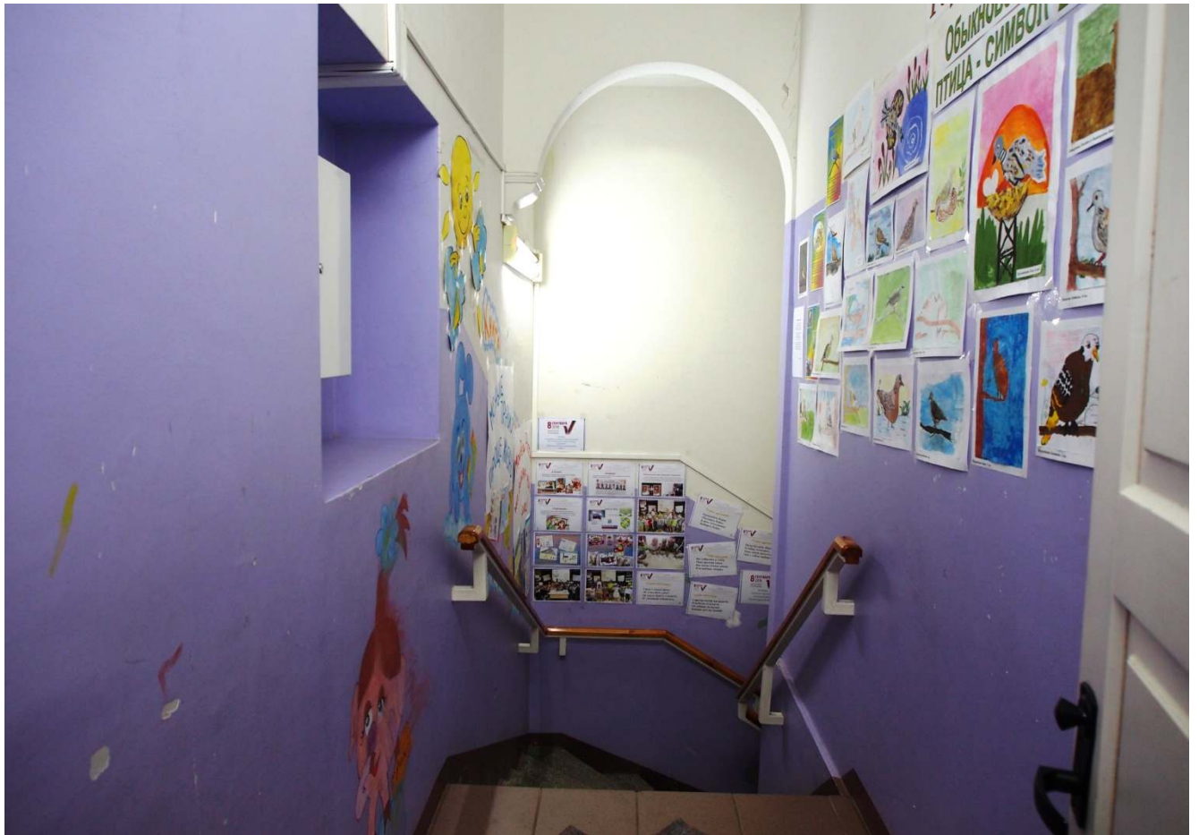
19. Площадка второго этажа лестницы в северной части здания.
