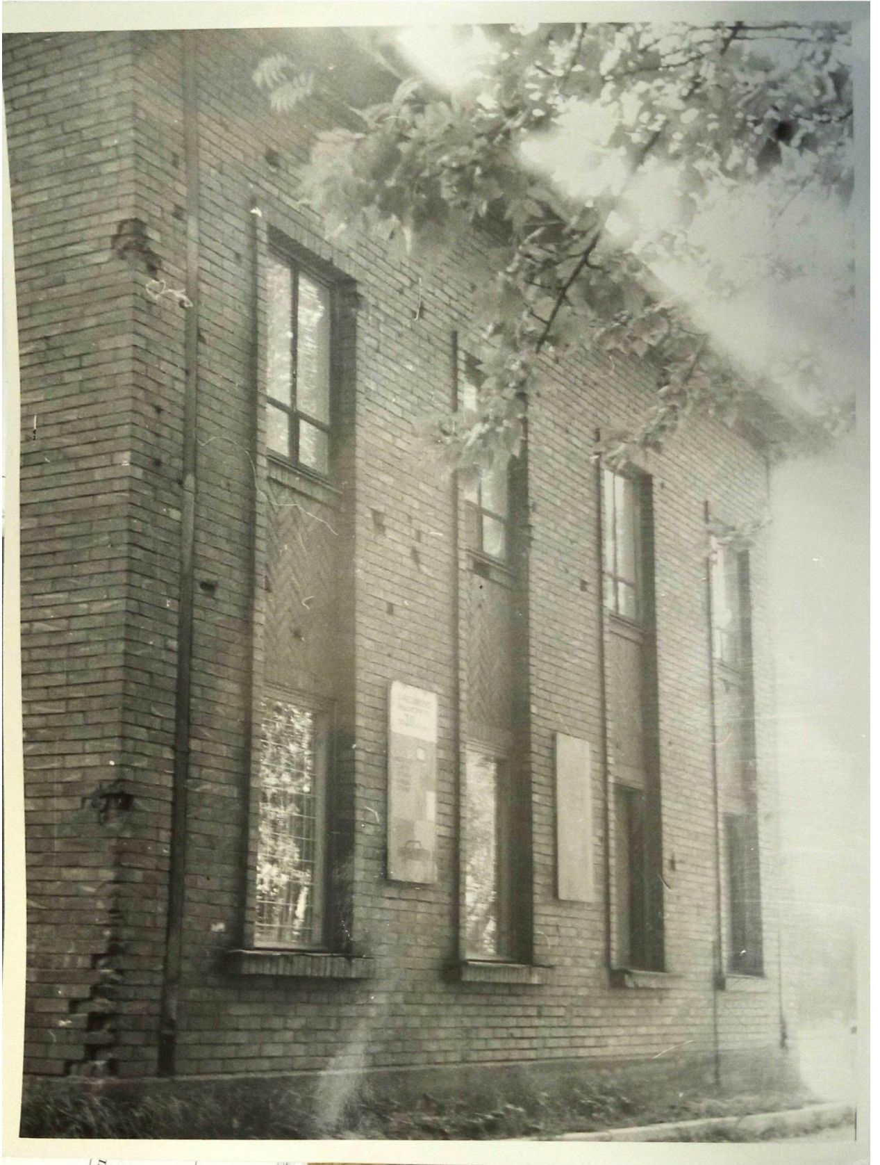
31. 1991 г. Фото здания аптеки из паспорта памятника истории и культуры. Дворовый фасад. Архив комитета по культуре Ленинградской области
