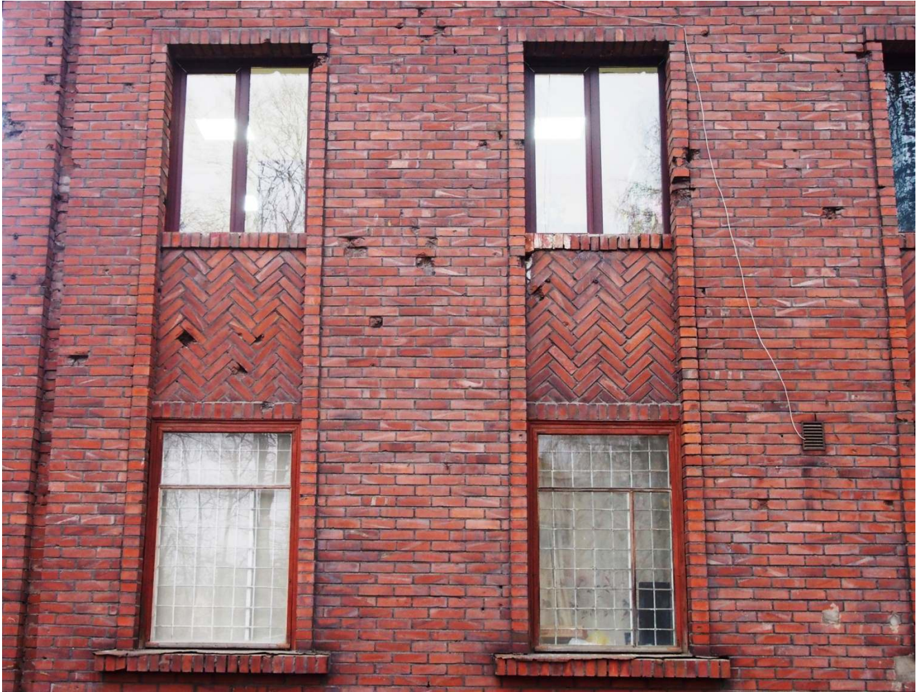
11. Фрагмент северного фасада. Оформление окон.
