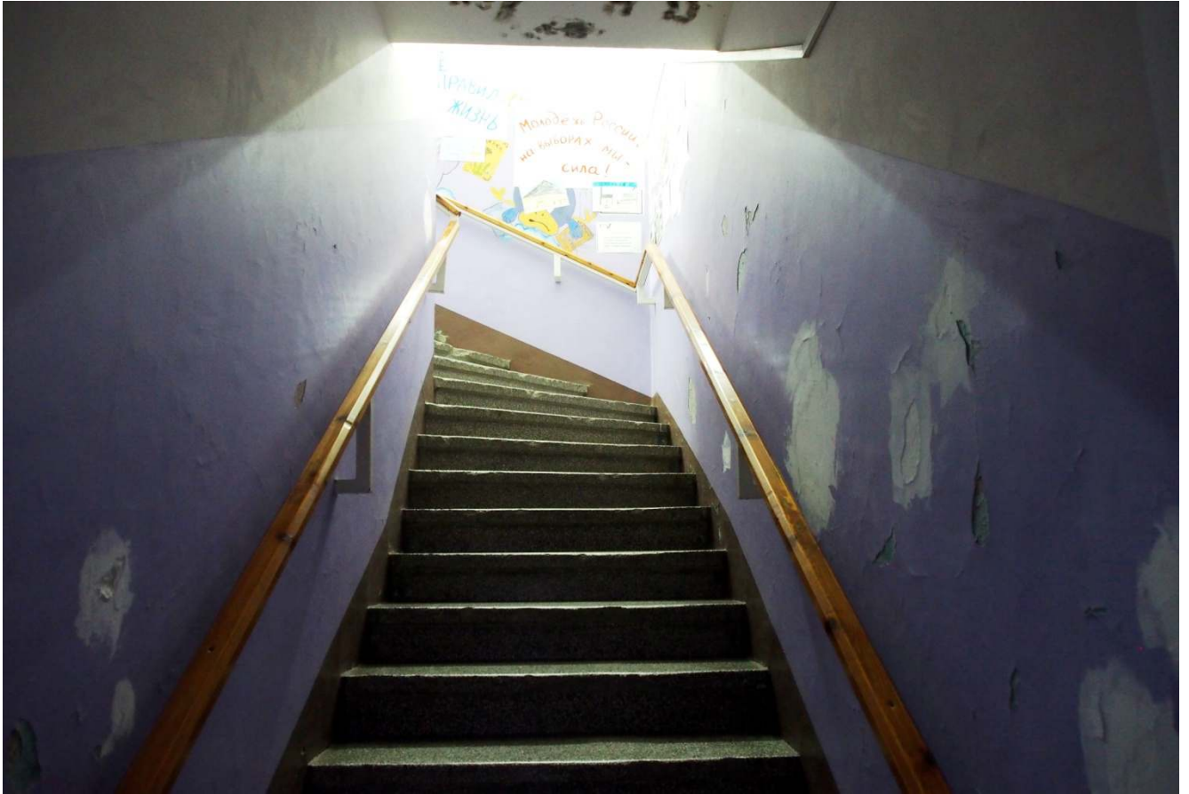
17. Лестница на второй этаж в северной части здания.
