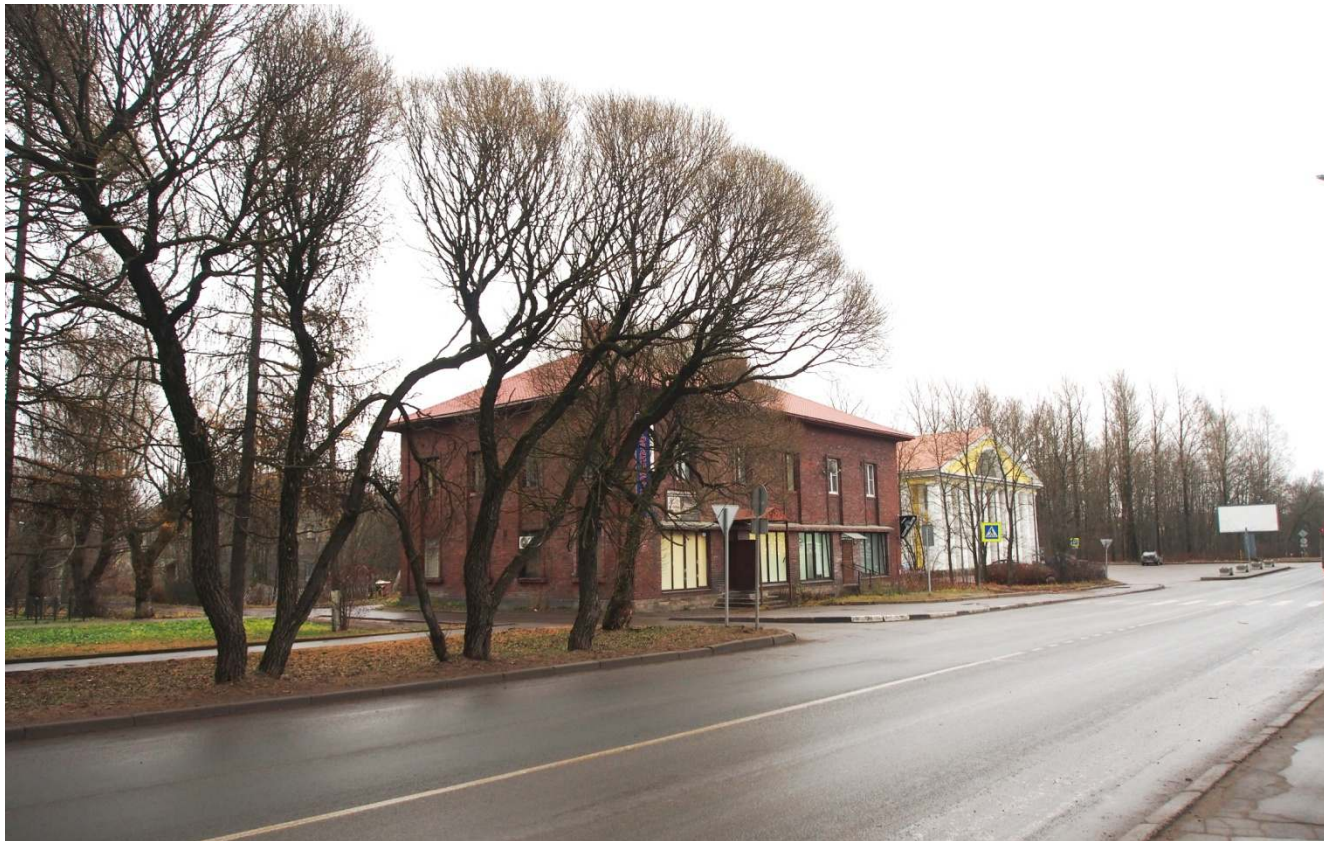
3. Общий вид здания с северо-запада, с ул. Победы.
