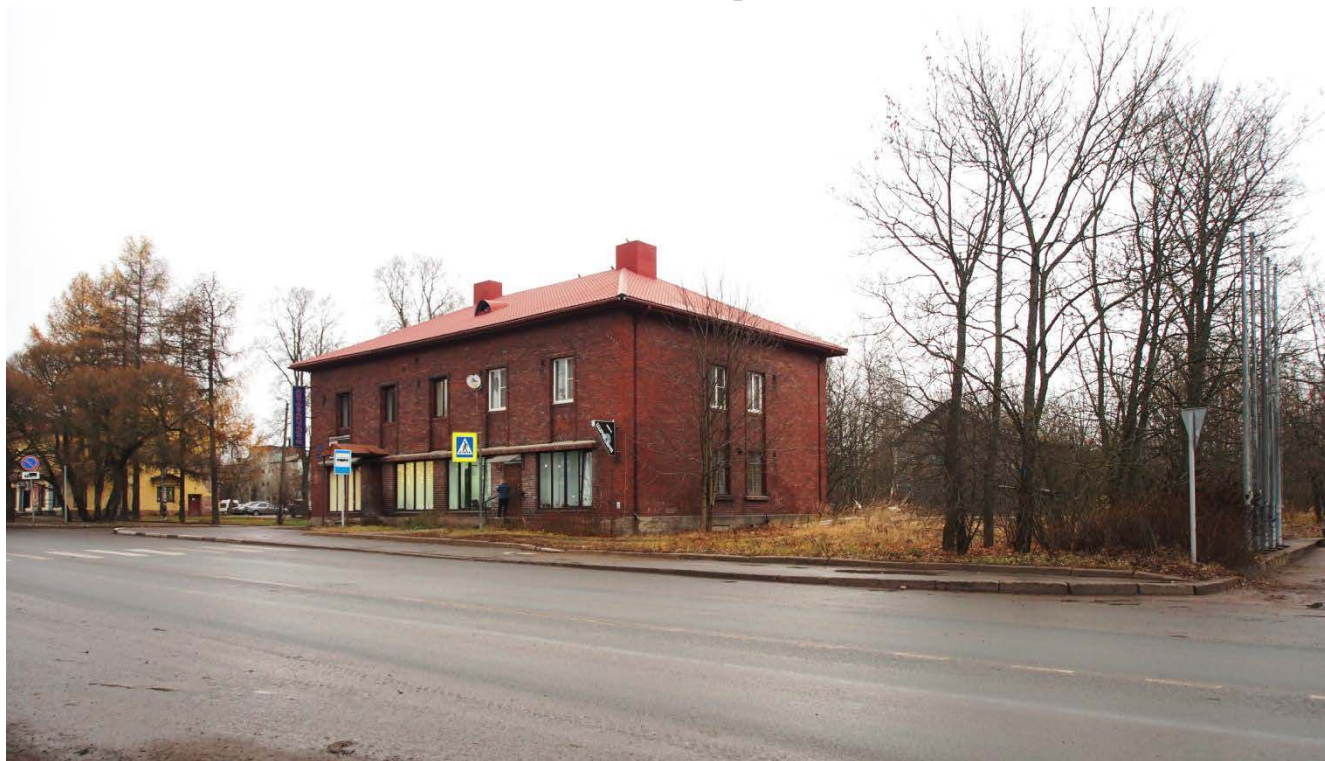
1. Общий вид здания с юга, с ул. Победы.
