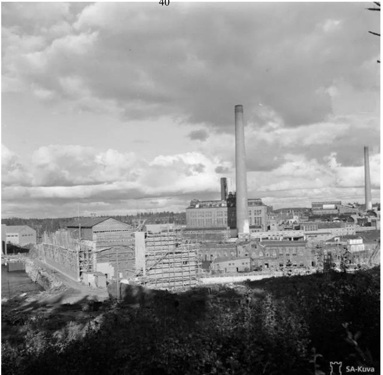
17.1944 г. Общий вид комбината Энсо-Гутцайт. Разрушения
