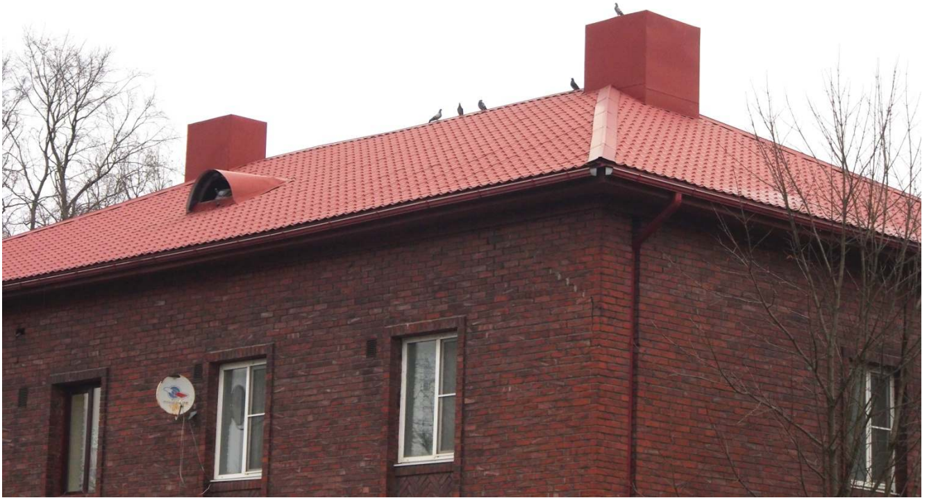
15. Фрагмент вальмовой крыши здания. Вид с юга.
