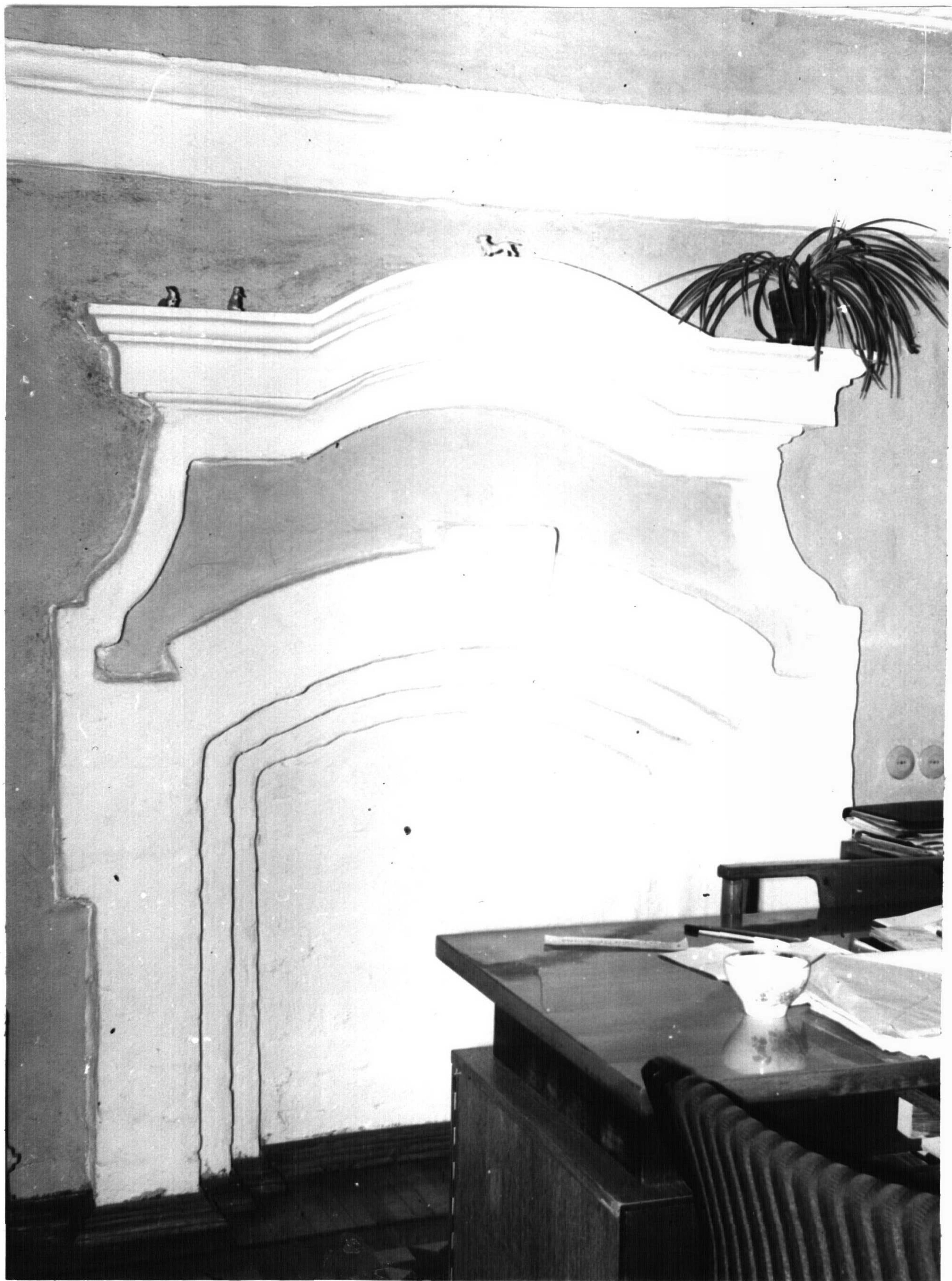
Москва, Ждановский р-н, Ульяновская ул., стр. 1. Городская усадьба, кон. XVIII - 2-й пол. XIX вв. Главный дом, кон. XVIII в. - 1870-е гг. Фрагмент оконного наличника сер. XVIII в. на внутренней стене 2-го этажа. Рейс И. С. Астарева, 1980 г.
