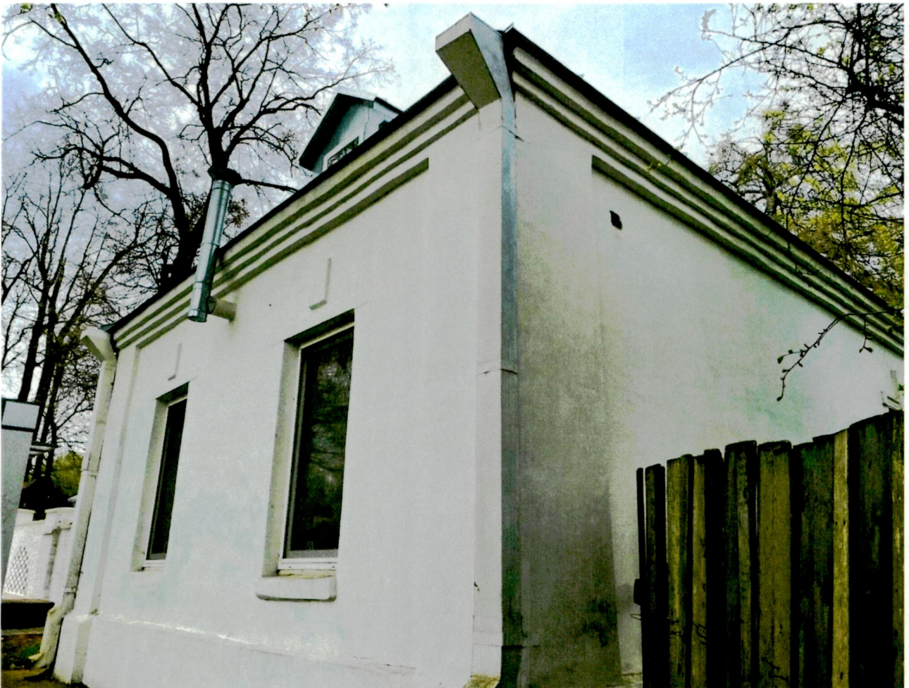
3. Общий вид с юго-запада
