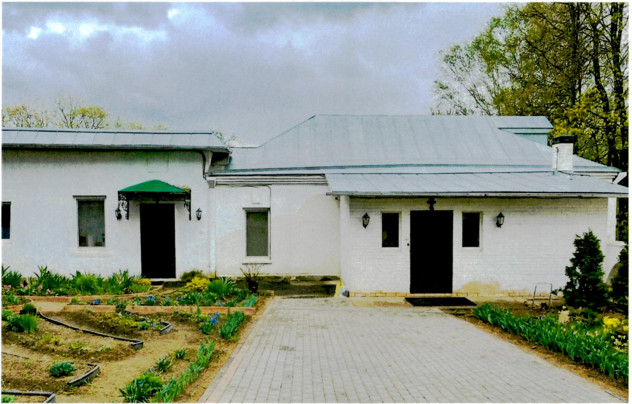
2. Общий вид северного фасада
