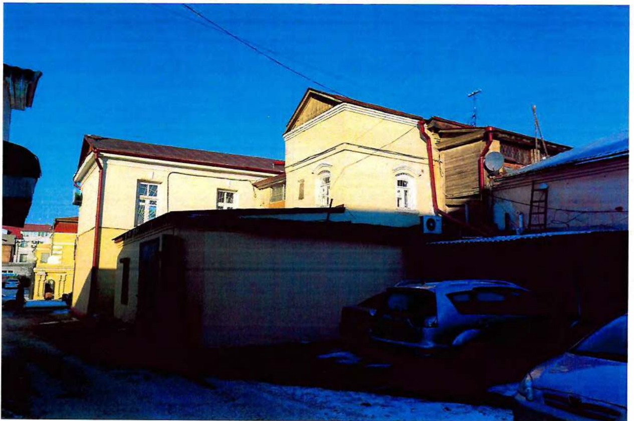
Фото 6. Общий вид с юго-запада.
