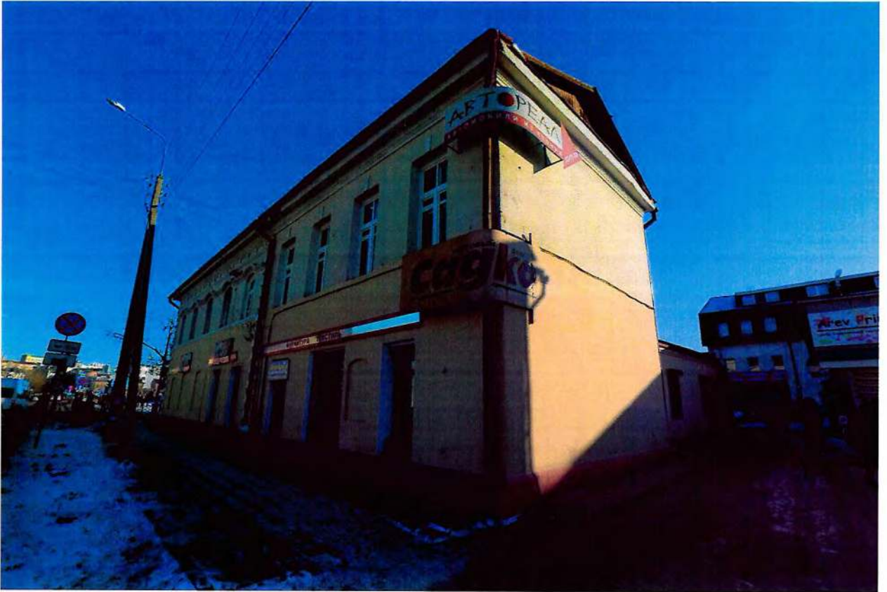
Фото 5. Общий вид с северо-запада.
