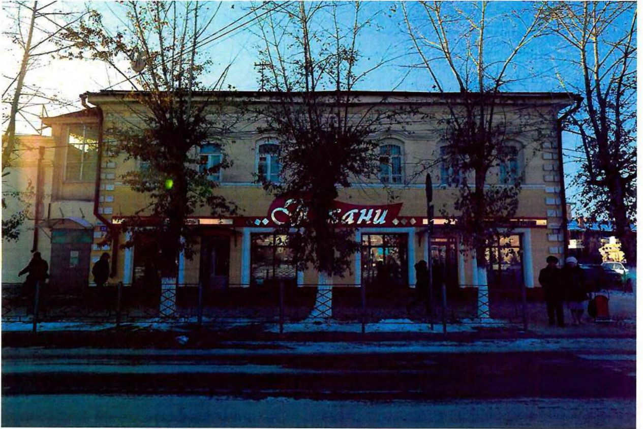
Фото 3. Общий вид с востока.
