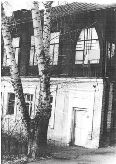
22 г. Кубарково, ул. Истомина, 2 Дом выходной Душечкиных 1911 г. Правый фланг юго-западного фасада
