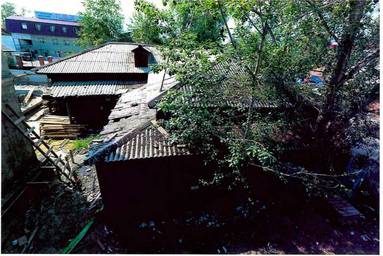
Фото 4. Общий вид с запада.
