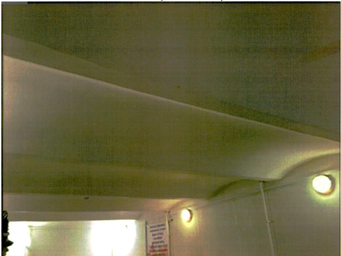
5. Своды Монье. В подвальном помещении.
