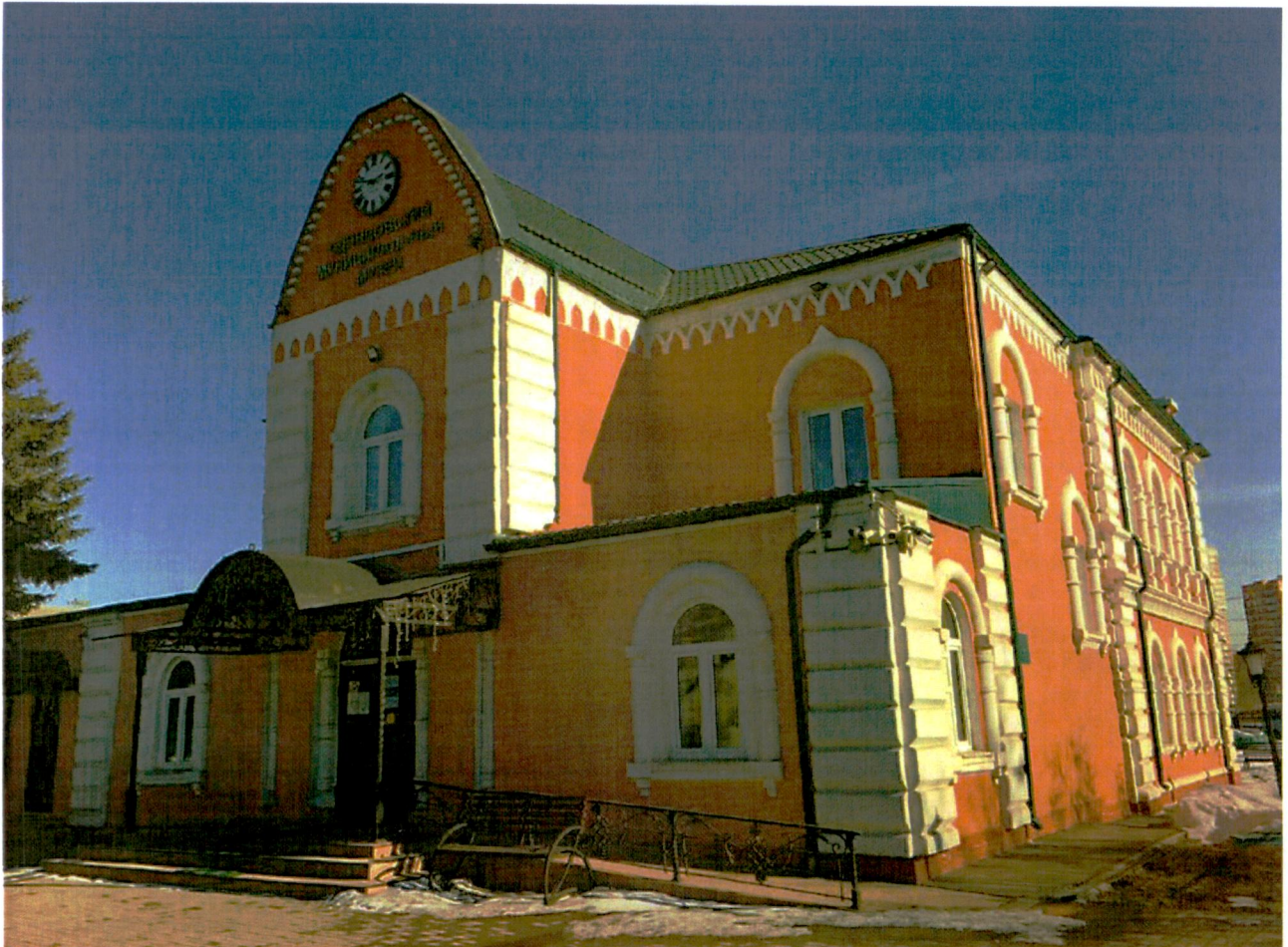
4. Общий вид на северо-западный угол здания.
