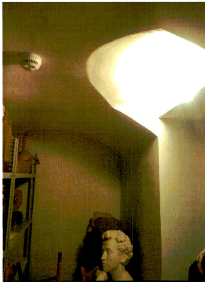
7. Коробовый свод с распалубкой центральной выступающей части юго-восточного фасада
