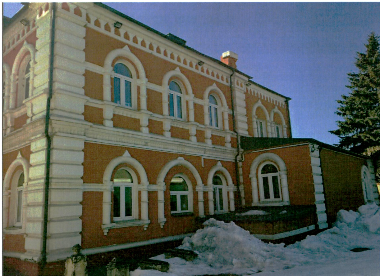
3. Вид на северо-восточный фасад здания
