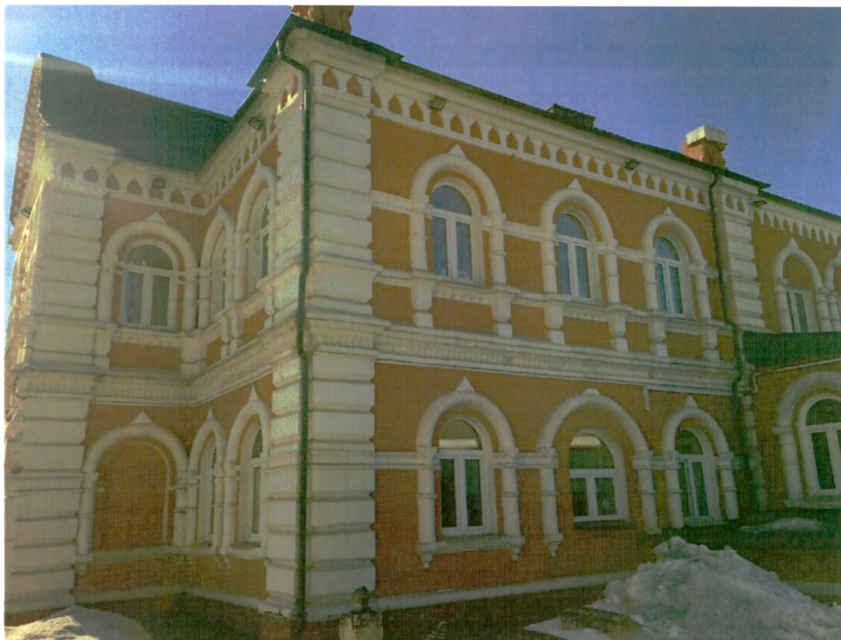
2. Вид на восточный угол здания
