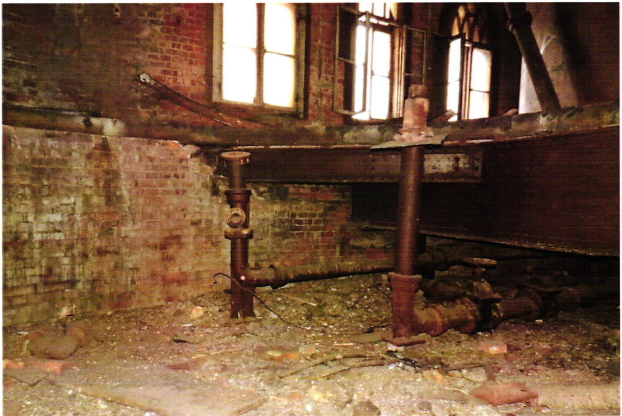
5. Металлические балки, поддерживающие баки для воды, кирпично-металлические основы под баки для воды
