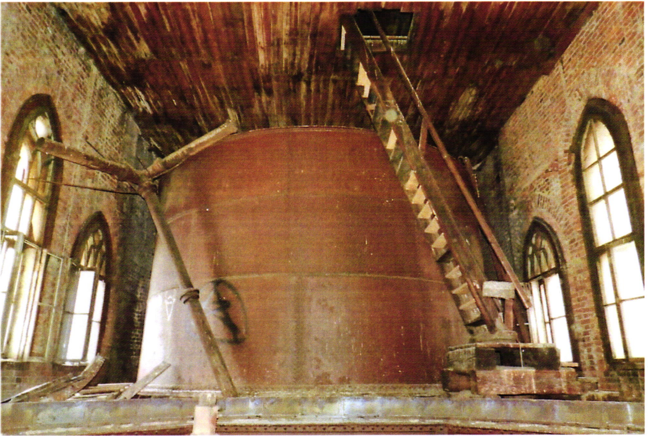
4. Бак водонапорной башни и лестница, ведущая на чердак
