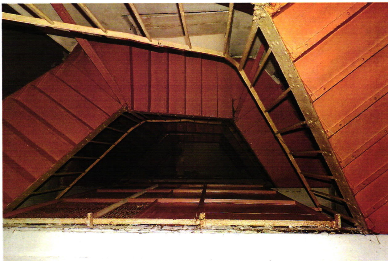
3. Внутренняя лестница. Вид сверху
