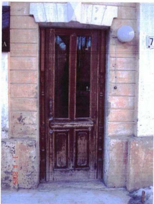
г. Хабаровск, ул. Калинина, 77 А Дом доходный Г.Н. Пырского, до 1914 г. Фрагмент главного, северо-восточного фасада. Фото Дыминской А.В. 2005 г.
