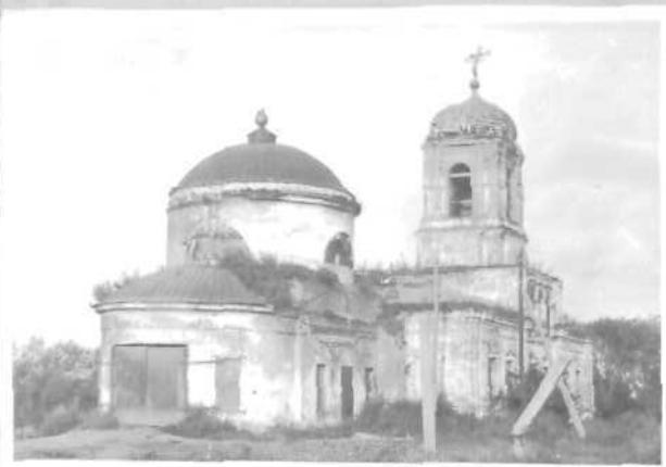
Церковь кирпичная, расположена в центре села и обладает крупными габаритами. Состоит из 2-х разновременных частей. Более ранней является кубический объем храма, переходящий в невысокий цилиндрический барабан, завершенный сферическим куполом. Барабан по сторонам света прорезан четырьмя полукруглыми окнами. Северный и южный фасады храма имеют по оси дверной проем прямоугольной формы, фланкированный прямоугольными окнами (по одному с каждой стороны).
