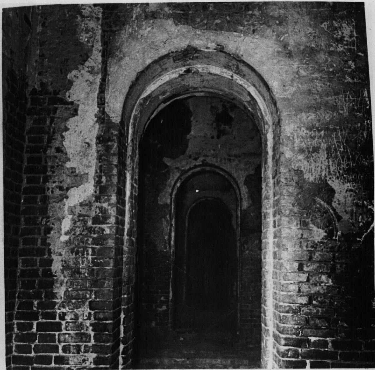
I-й этаж. Помещение 9. Южная стена. Вход в помещение 10.
