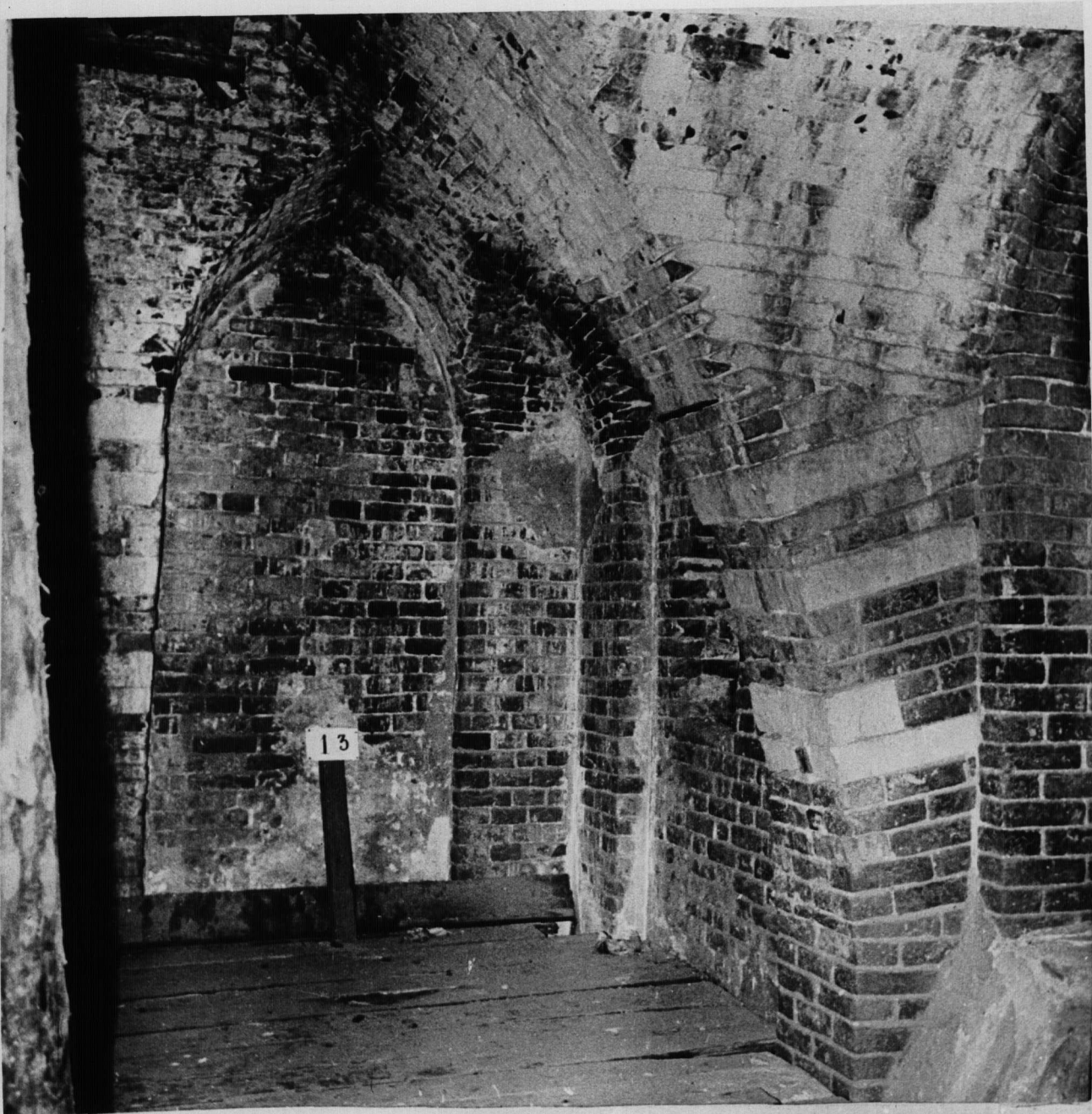
Помещение 3. Северо-западный угол. Ниша на западной стене.
