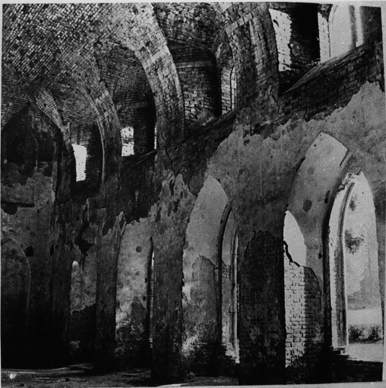
Помещение 2. Восточная стена. Фото 1975 года.
