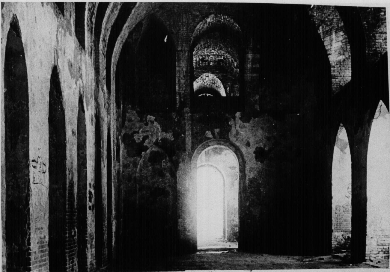
Помещение 2. Северная стена. Фото 1975 года.
