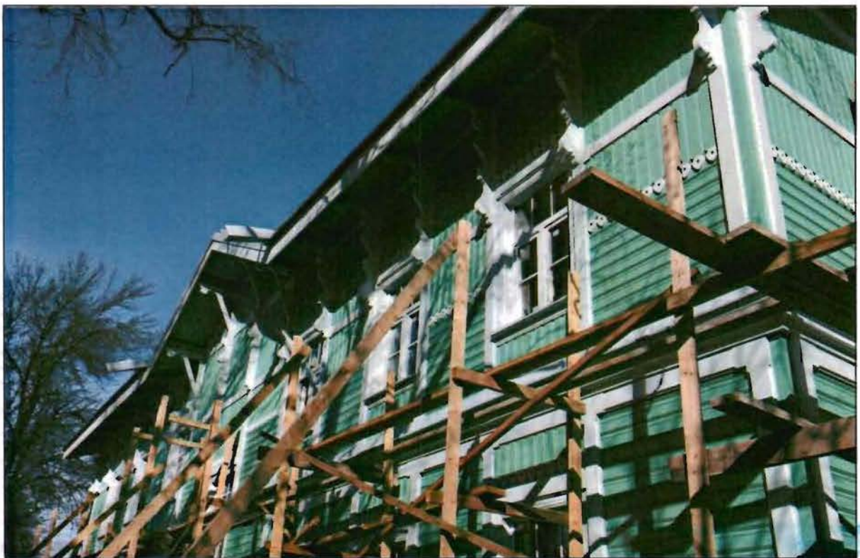
Фото 1. Восточный фасад. Общий вид.
