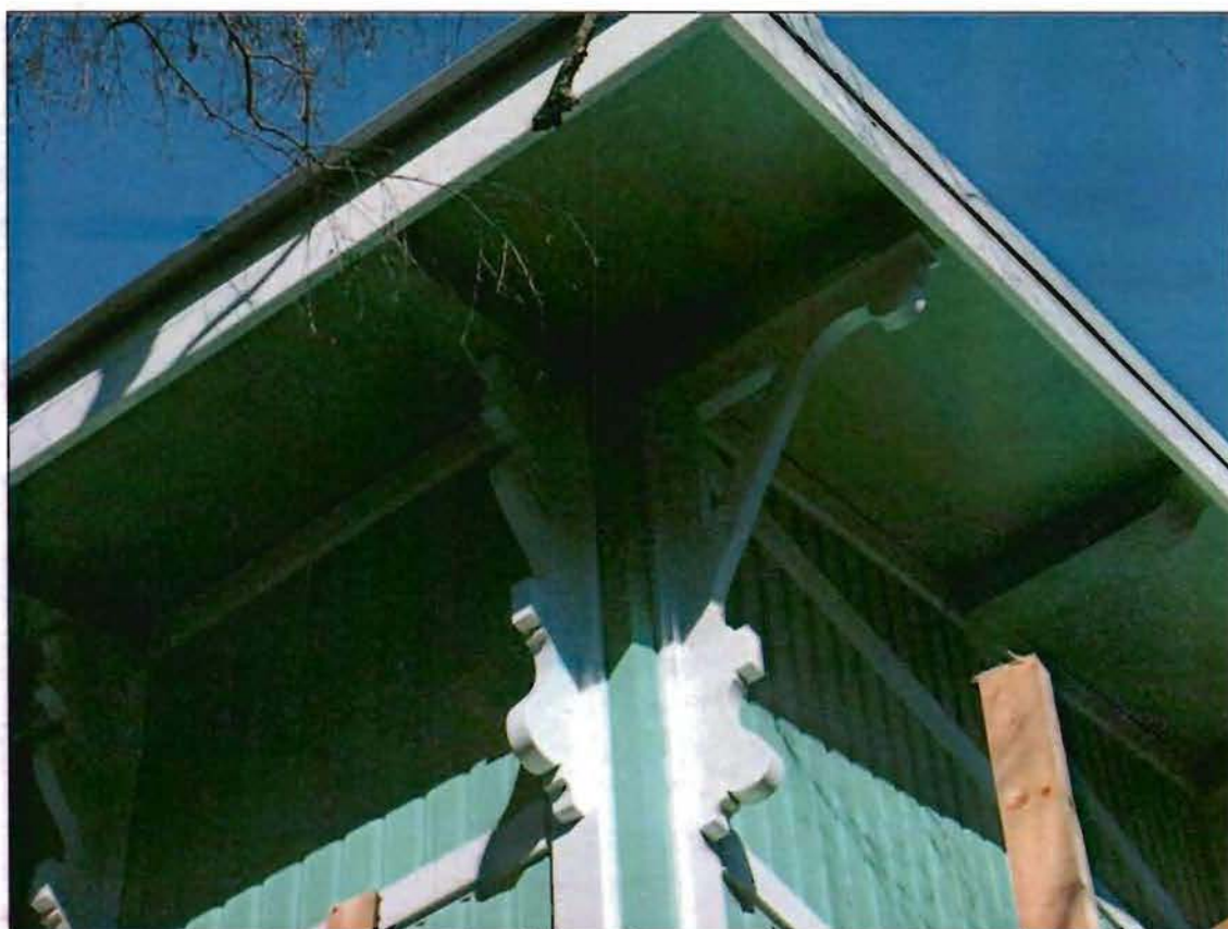
Фото 3. Южный фасад. Фрагмент. Кронштейны венчающего карниза.
