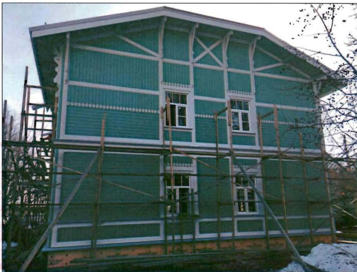
Фото 2. Южный фасад. Общий вид.
