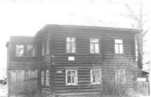
Расположен главным фасадом по красной линии улицы. Положение рядовое. Дом двухэтажный в виде параллелепипеда с вальмовым покрытием. К боковому фасаду пристроены двухэтажные сени с внутренней лестницей, крытые на один скат. Второй вход - через открытые крыльца со стороны двора. Главный фасад симметричен на три окна, лишен каких-либо декоративных деталей.
