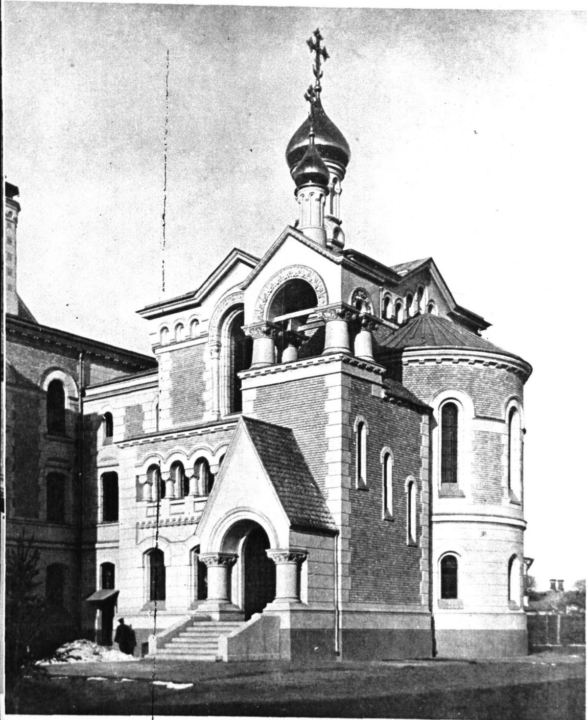
Деталь фасада церкви.
