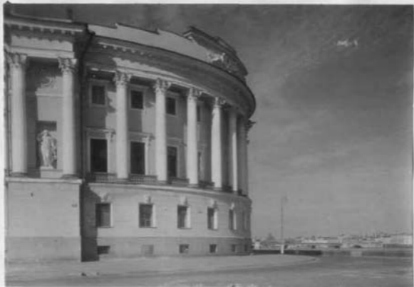
Фрагмент фасада здания Сената.
