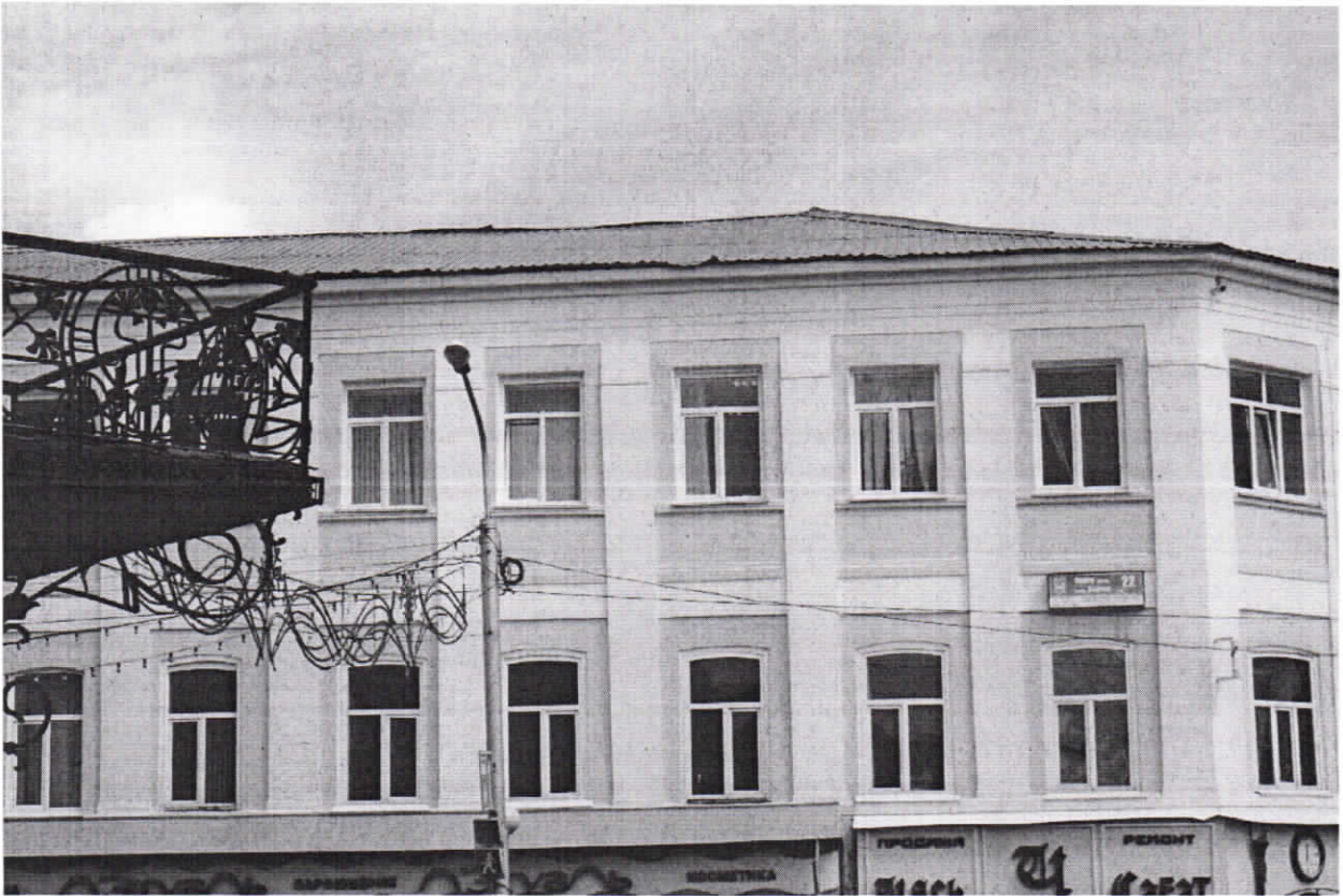
Фото 6. Фрагмент северо-западного лицевого фасада и фрагмент юго-западного фасада. Симметричная трёхчастная схема членения композиции главенствующих фасадов, выходящих на пересечение улиц; угловой акцент с закруглением угла объема юго-западного фасада; пилястры, членящие фасады вертикально; междуэтажные пояса второго и третьего этажей; прямоугольные оконные проемы третьего этажа; лучковые оконные проемы второго этажа; упрощенный фриз; упрощенный карниз. Дата фотографии 15 июня 2018 года.
