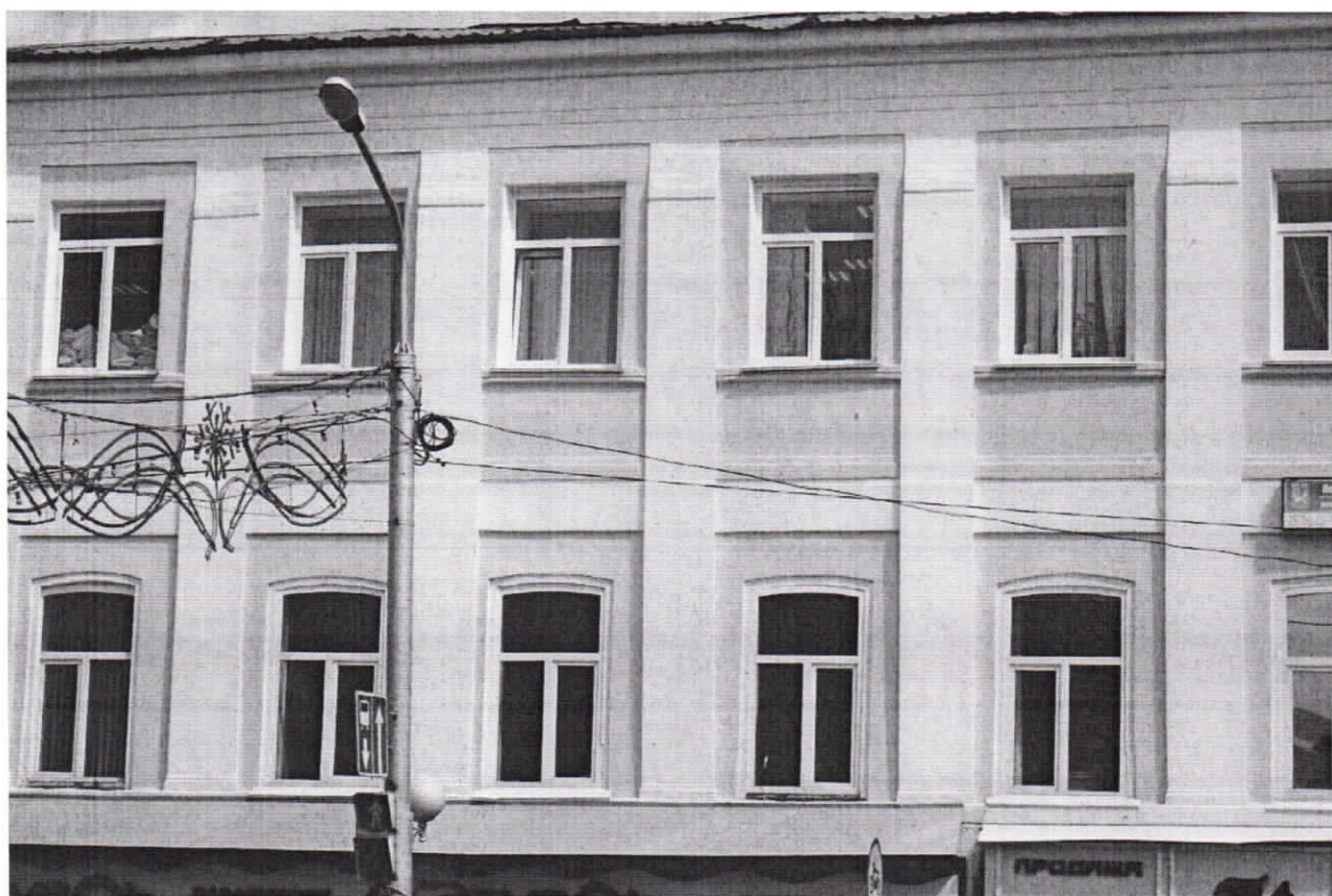
Фото 7. Фрагмент северо-западного лицевого фасада. Пилястры, членящие фасады вертикально; междуэтажный пояс второго и третьего этажей; прямоугольные оконные проемы третьего этажа; лучковые оконные проемы второго этажа; упрощенный фриз; упрощенный карниз. Дата фотографии 15 июня 2018 года.
