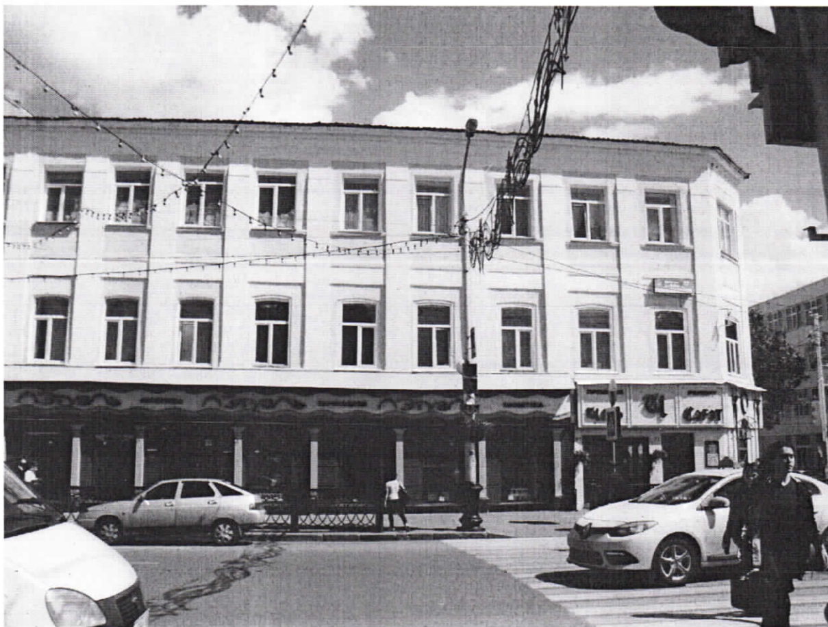
Фото 2. Фрагмент северо-западного лицевого фасада и юго-западный фасад. Трехэтажное кирпичное оштукатуренное и окрашенное здание, в плане сложной конфигурации, с поздними разноэтажными пристроями. Дата фотографии 20 июня 2018 года.
