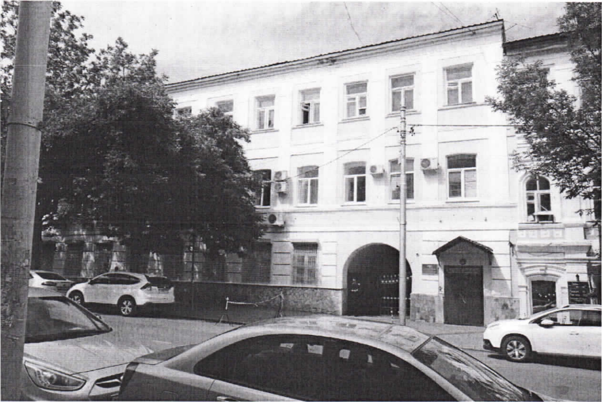
Фото 16. Фрагмент южного лицевого фасада. Симметричная трёхчастная схема членения композиций главенствующих фасадов, выходящих на пересечение улиц; междуэтажные пояса первого и второго, и второго и третьего этажей; сквозной арочный проезд, расположенный со стороны улицы Октябрьской Революции; прямоугольные оконные проемы первого и третьего этажей; лучковые оконные проемы второго этажа; упрощенный фриз; упрощенный карниз. Дата фотографии 15 июня 2018 года.
