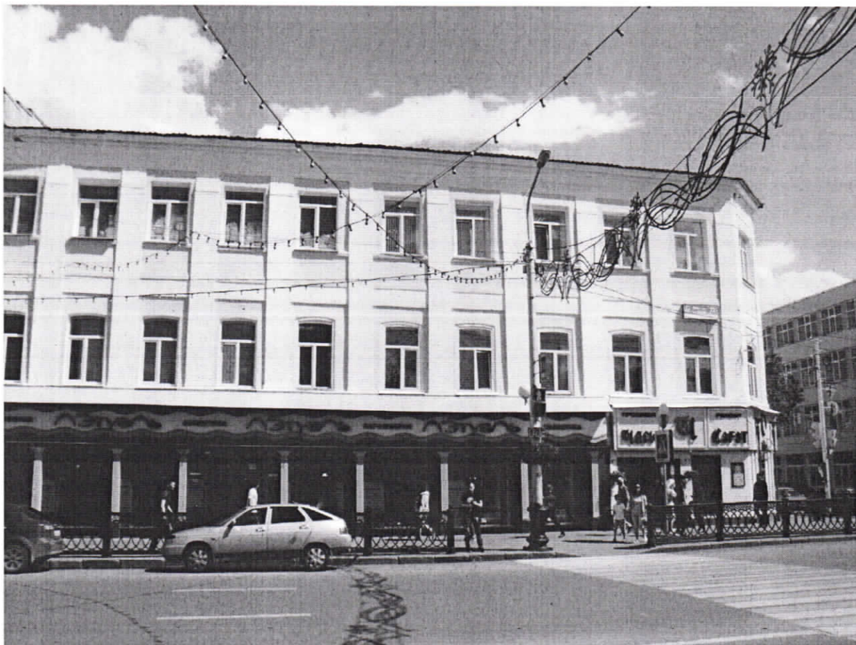
Фото 4. Фрагмент северо-западного лицевого фасада и фрагмент юго-западного фасада. Форма, габариты и характеристики трехэтажного кирпичного оштукатуренного и окрашенного здания с примыкающими к нему поздними пристроями, сложившиеся в ходе его строительства и последующей эксплуатации. Дата фотографии 20 июня 2018 года.
