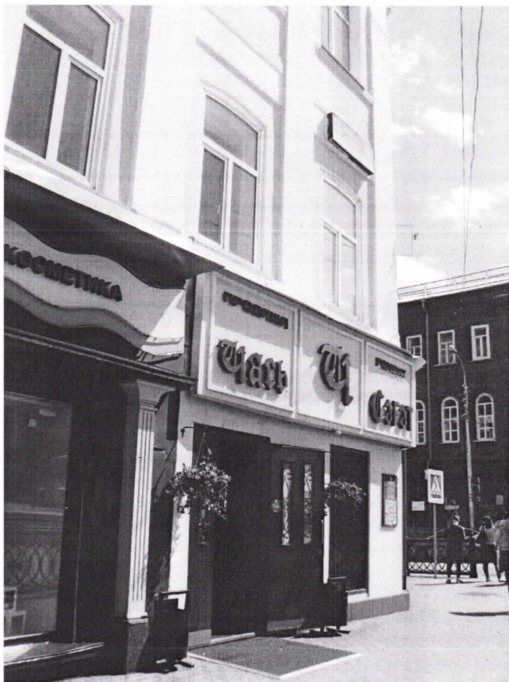
Фото 11. Фрагмент северо-западного лицевого фасада. Здание, расположенное на пересечении улиц Ленина и Октябрьской Революции города Уфы, являющееся частью исторической застройки центра города Уфы конца XIX - начала XX веков. Дата фотографии 20 июня 2018 года.
