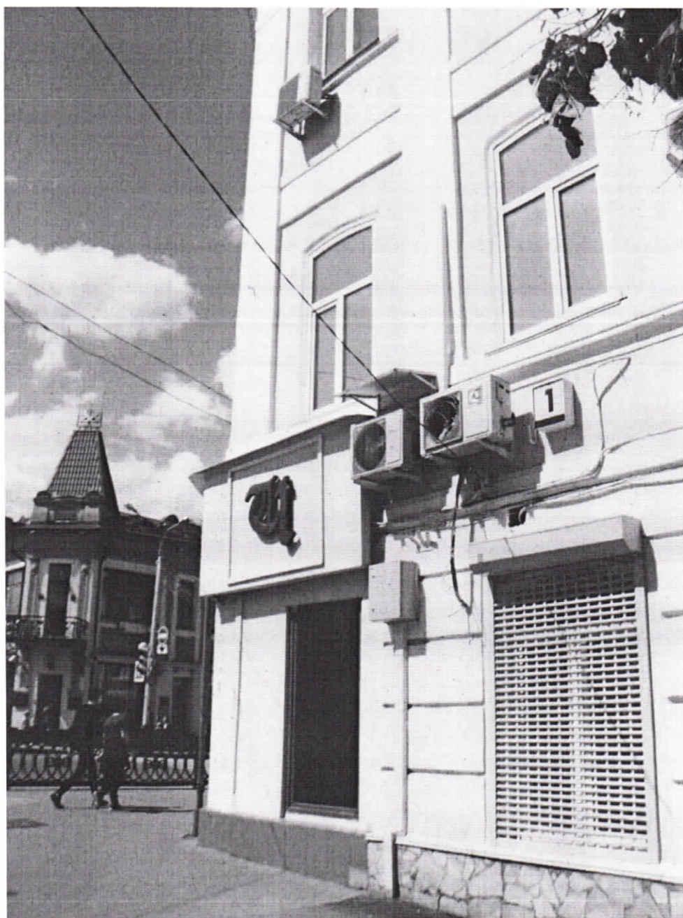
Фото 12. Фрагмент южного лицевого фасада. Пилястры, междуэтажные пояса первого и второго этажей; прямоугольные оконные проемы первого и третьего этажей; лучковые оконные проемы второго этажа. Дата фотографии 20 июня 2018 года.
