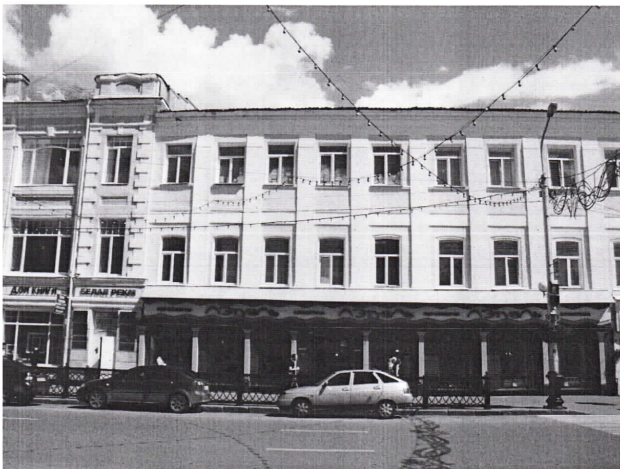
Фото 3. Фрагмент северо-западного лицевого фасада. Трехэтажное кирпичное оштукатуренное и окрашенное здание, в плане сложной конфигурации, с поздними разноэтажными пристроями. Дата фотографии 20 июня 2018 года.
