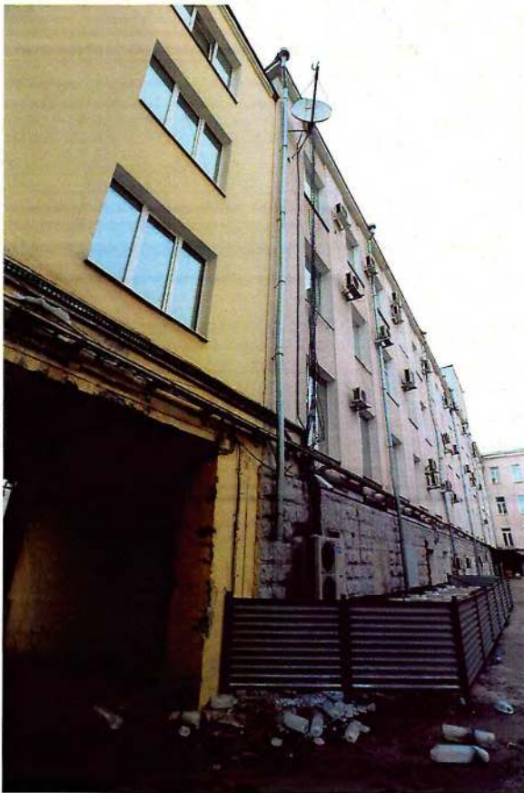
Фото 6. Восточный дворовый фасад.
