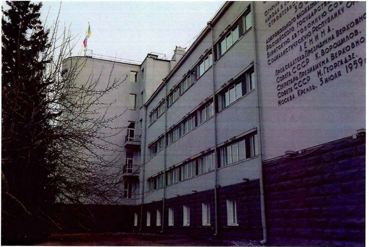
Фото 3. Западный фасад. Фрагмент.
