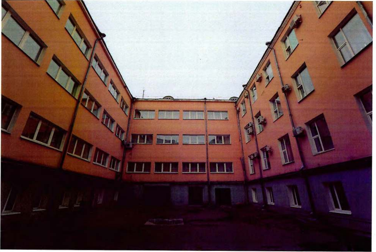
Фото 10. Дворовые фасады. Фрагмент.
