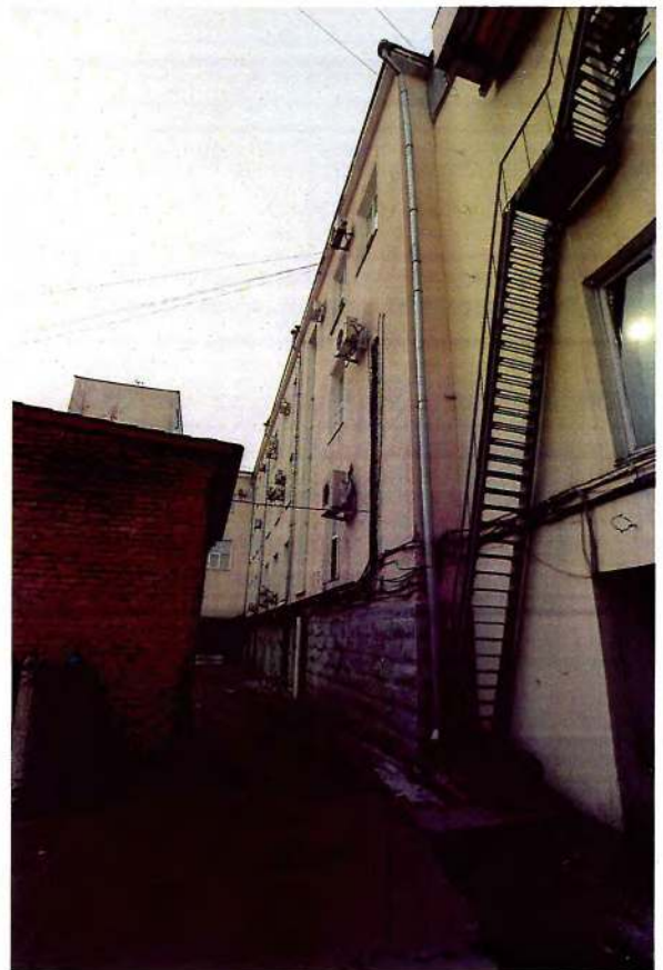
Фото 7. Южный дворовый фасад.
