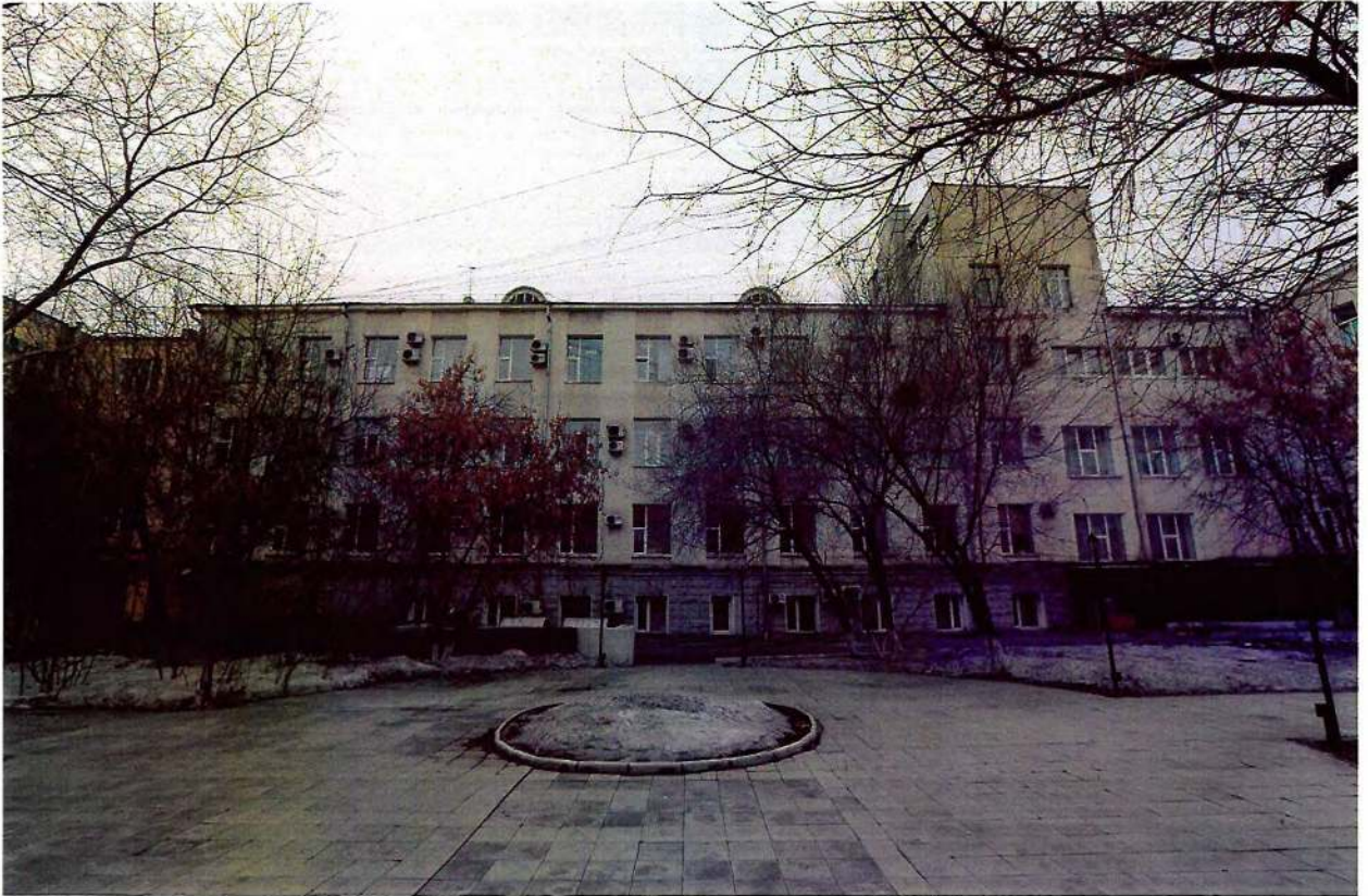
Фото 5. Восточный дворовый фасад.
