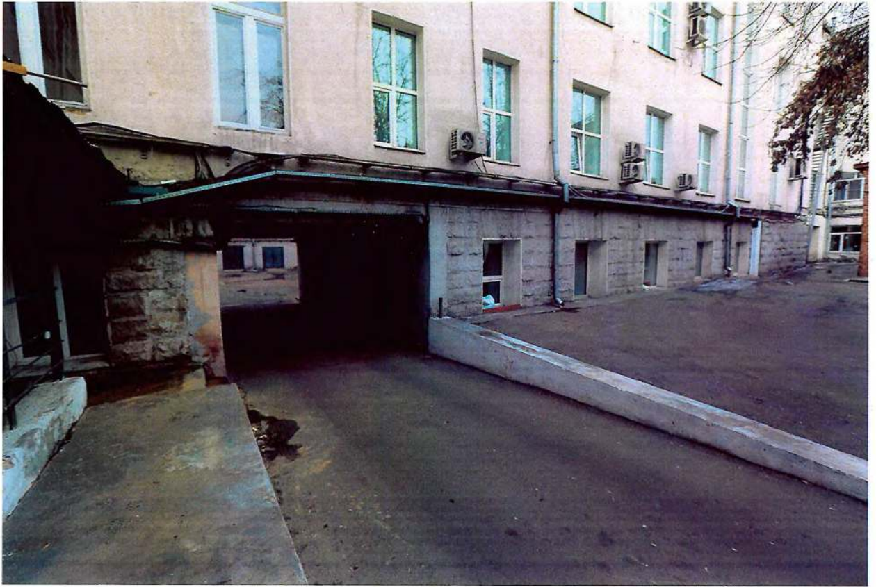
Фото 8. Проезд в здании.
