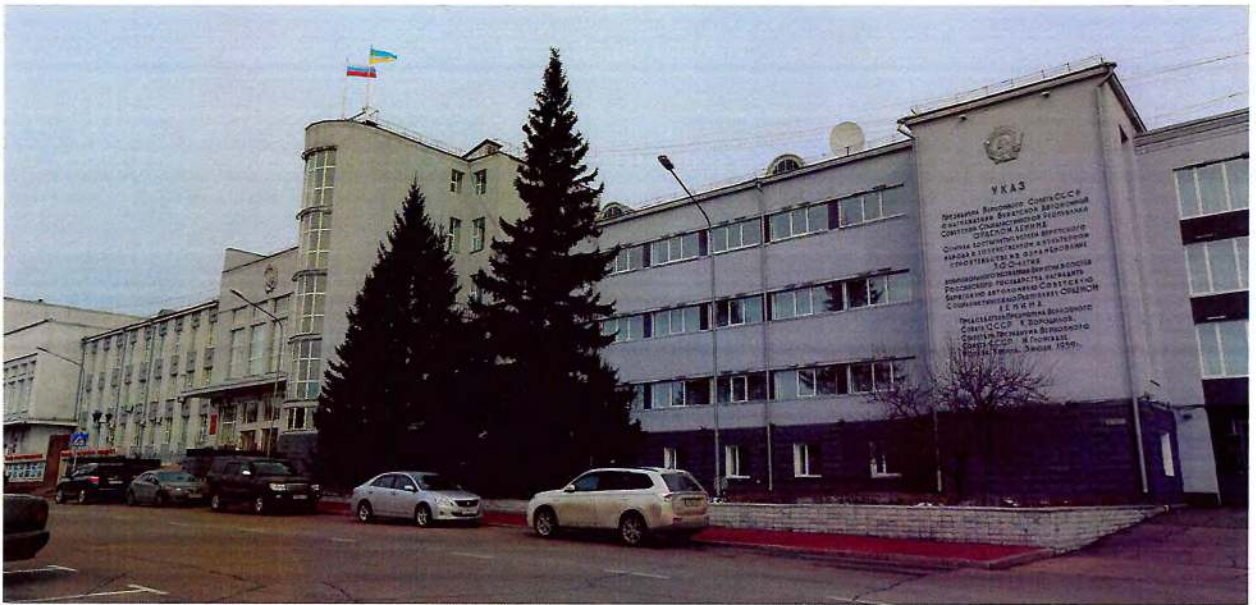
Фото 1. Общий вид с юго-запада.
