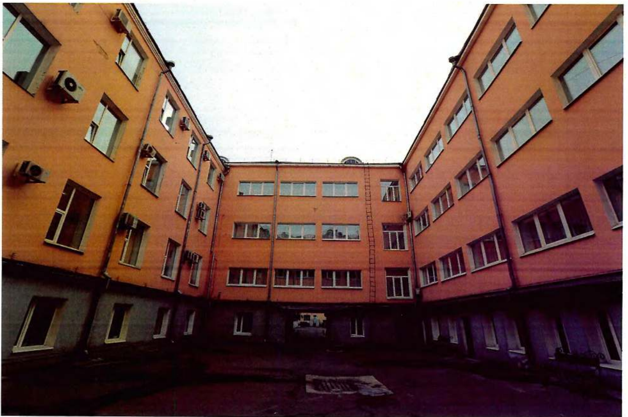
Фото 9. Дворовые фасады. Фрагмент.
