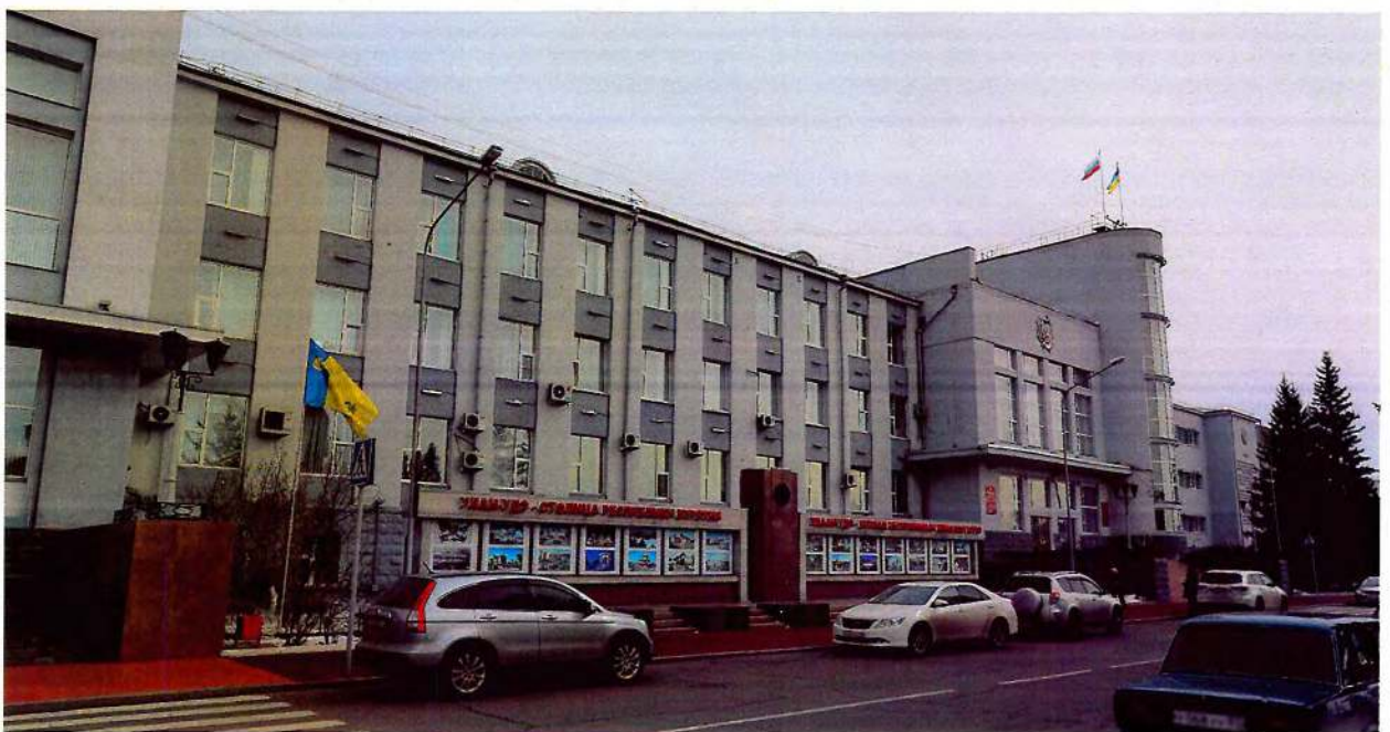
Фото 2. Общий вид с северо-запада.
