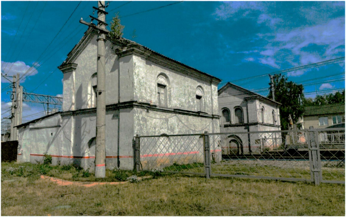
2. Общий вид комплекса с юга со стороны улицы 2-я Урицкого.
