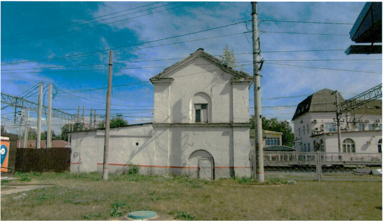
6. Западная башня. Западный фасад со стороны улицы 2-я Урицкого.
