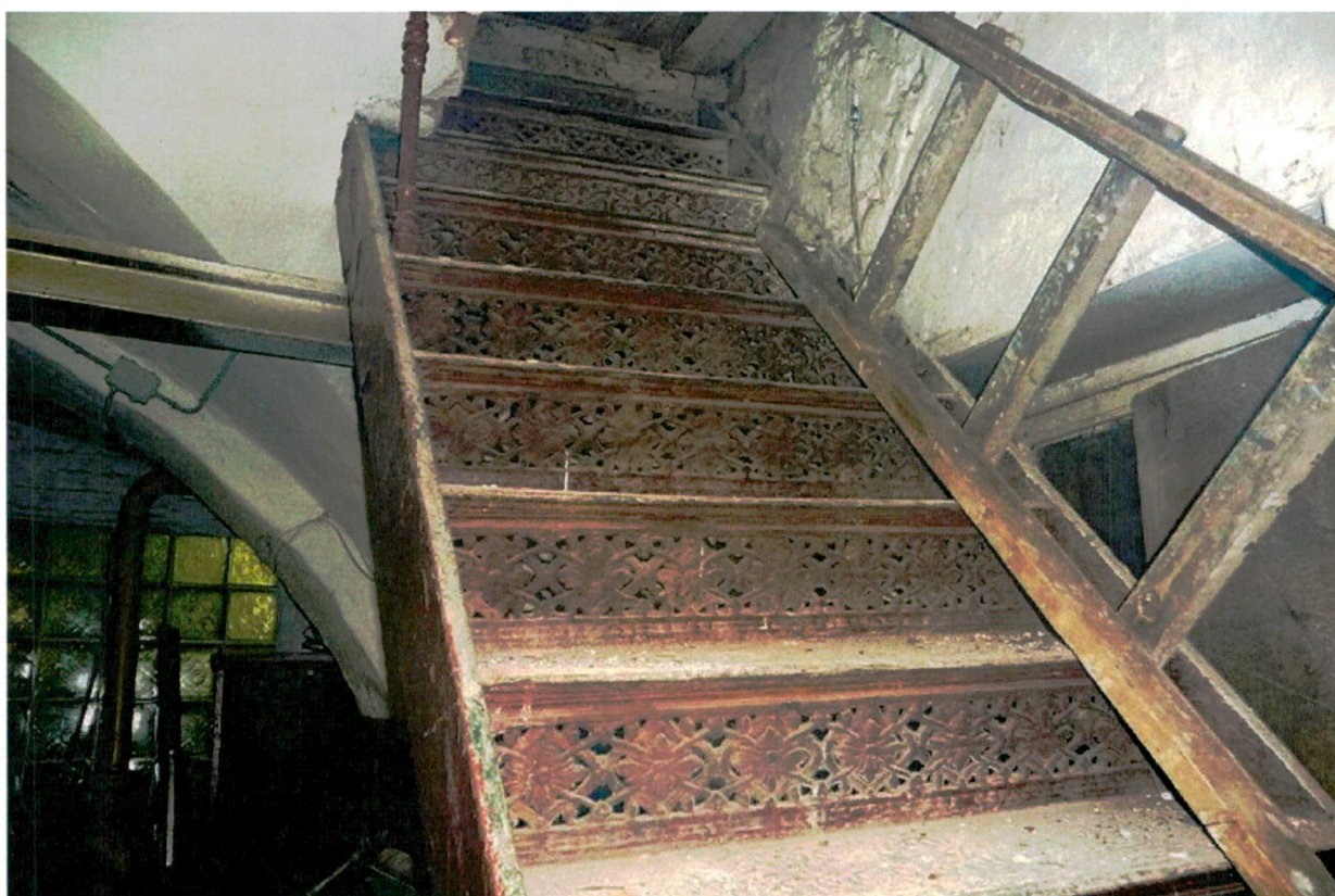
9. Чугунная лестница на 2-й этаж в восточной башне (компрессорная).
