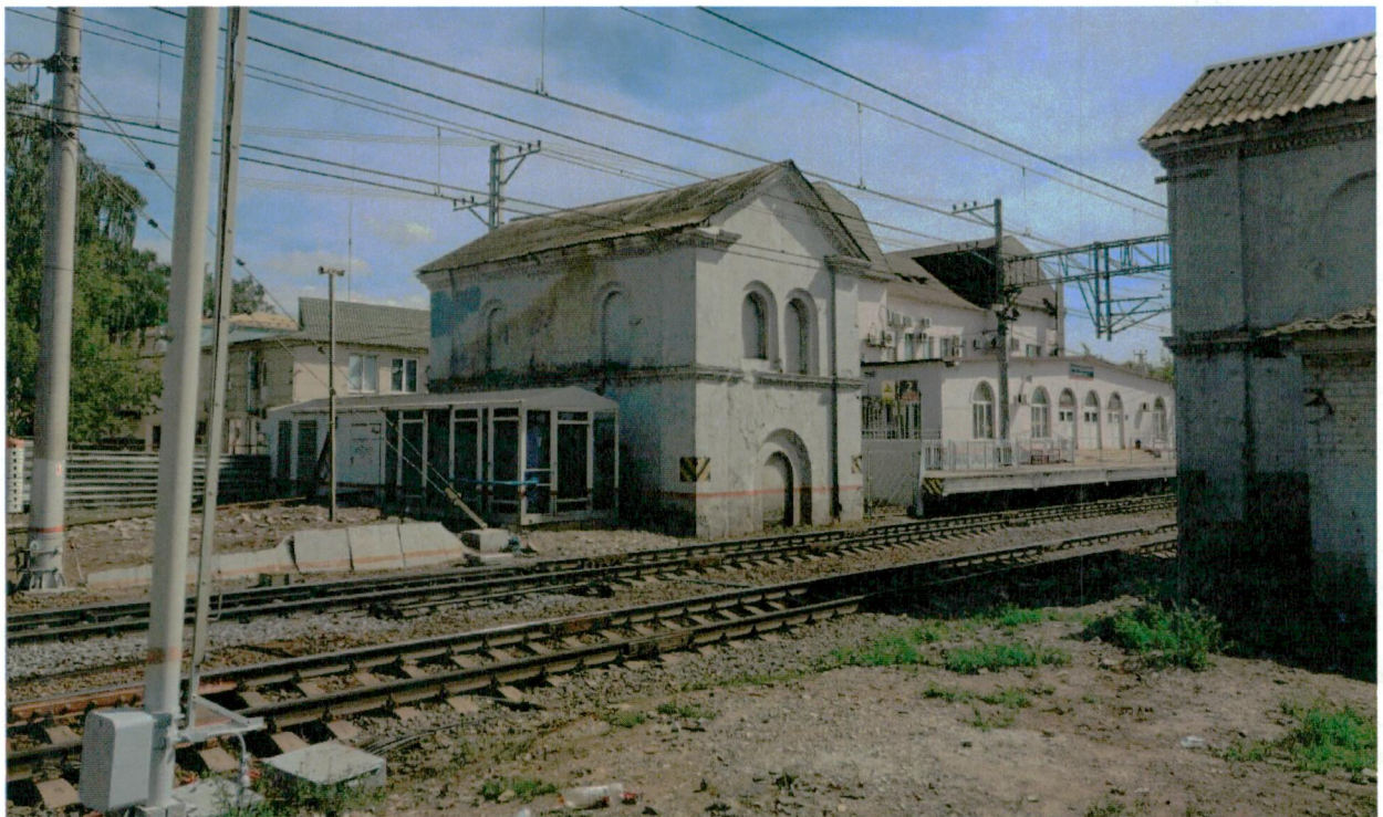
5. Восточная башня. Общий вид с северо-востока.
