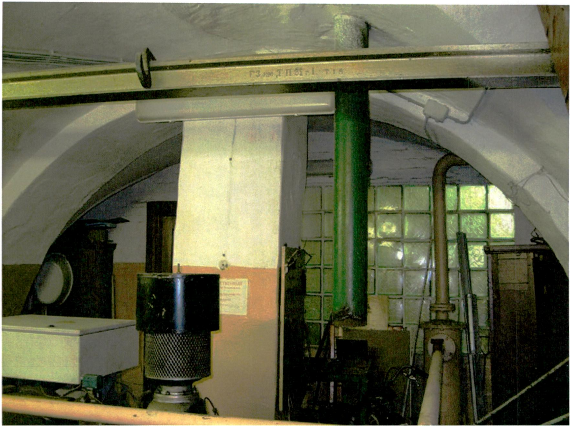
10. Сводчатые перекрытия 1-го этажа восточной башни.
