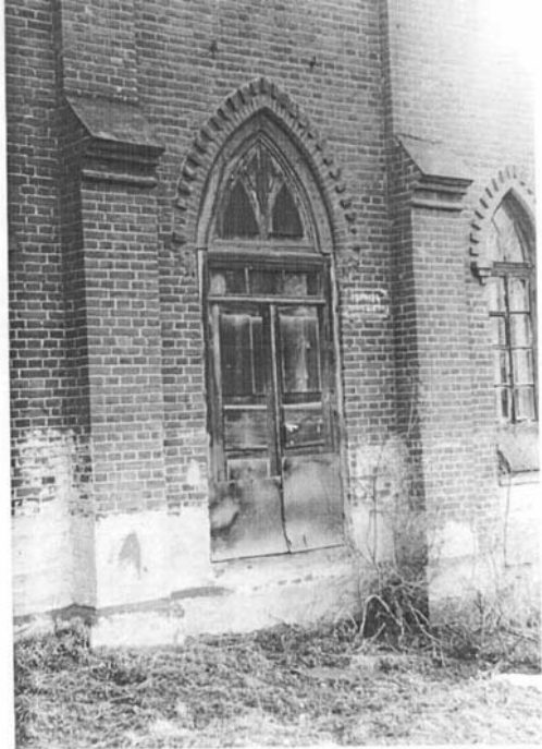
⑤ г. Хаскировск, ул. Комсомольская, 18 Комплексе зданий артиллерийского склада. 1873 - 1918 гг. Артиллерийский склад, 1886 г. Средняя восточная часть западного флигеля.
