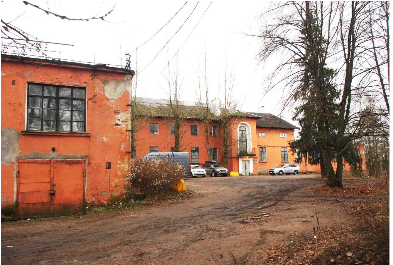
5. Вид здания с северо-востока.
