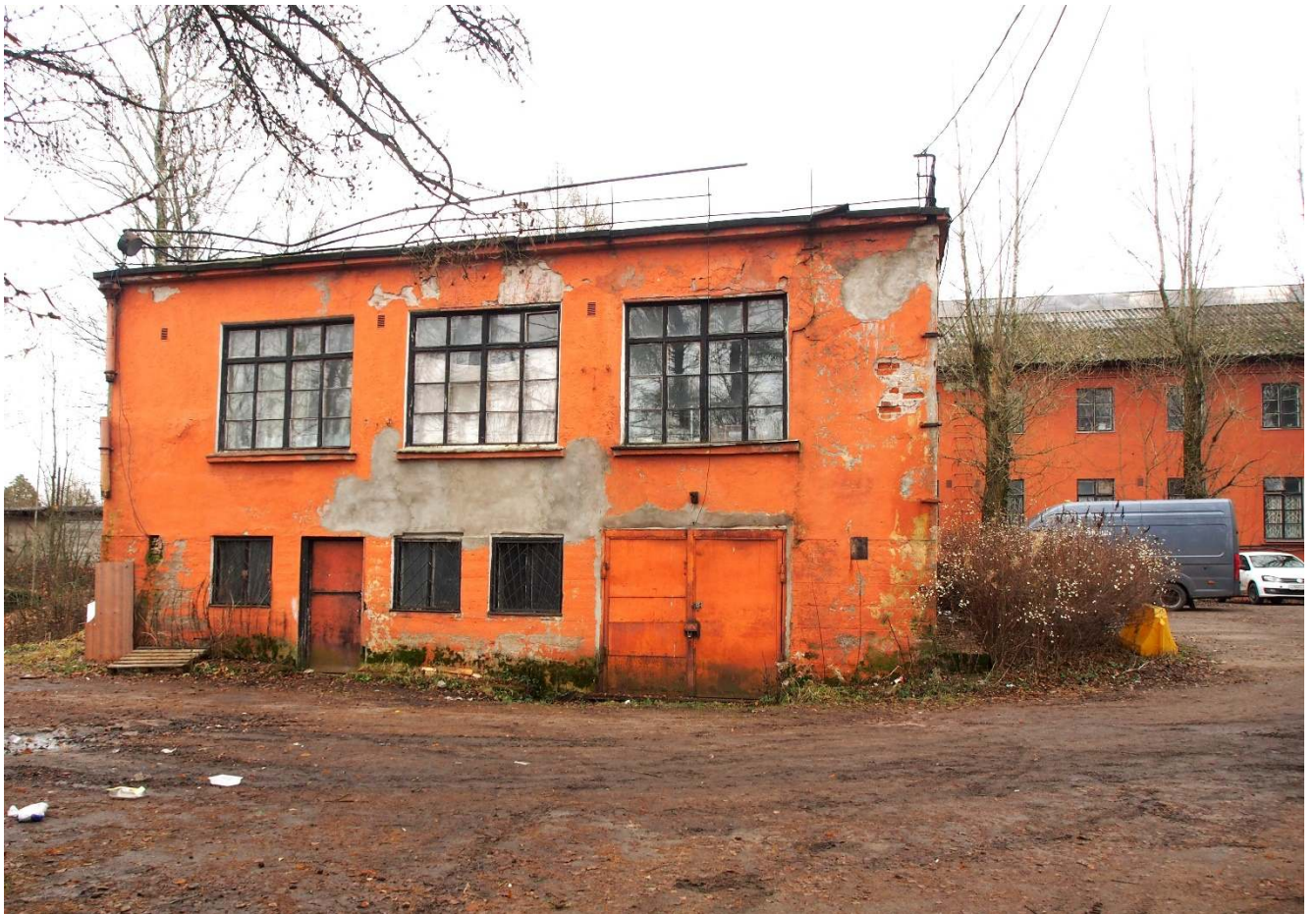
6. Северный фасад одноэтажной части здания (восточной).
