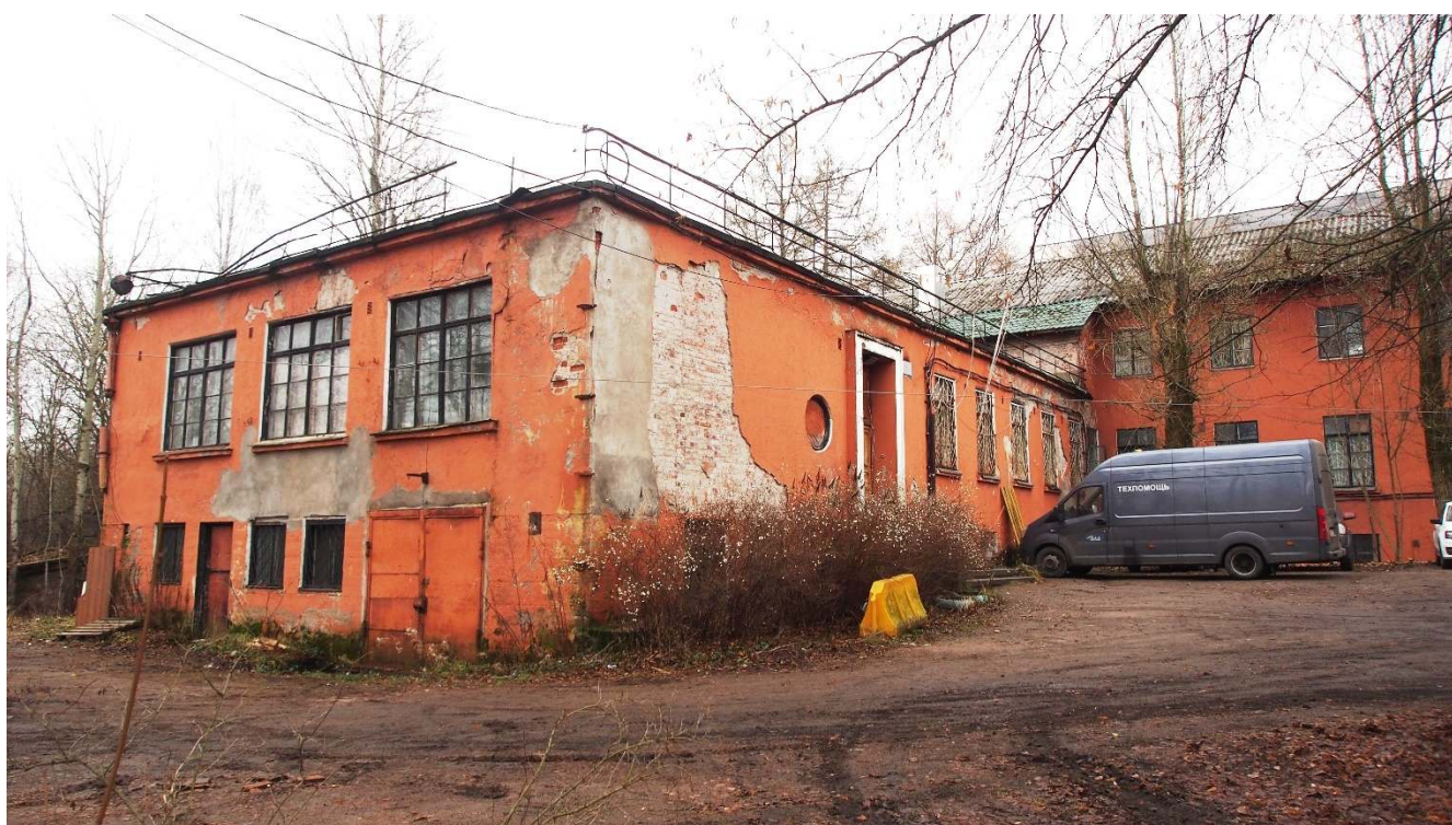
4. Одноэтажная часть здания (восточная). Вид с запада.
