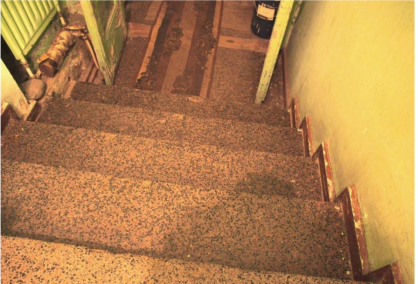
35. Бетонная лестница в вестибюле одноэтажной (восточной) части здания.
