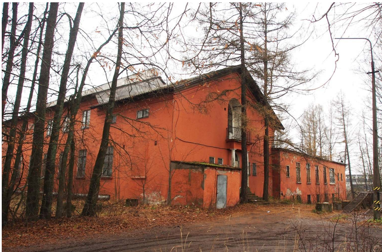
8. Восточный фасад. Вид с юго-востока.
