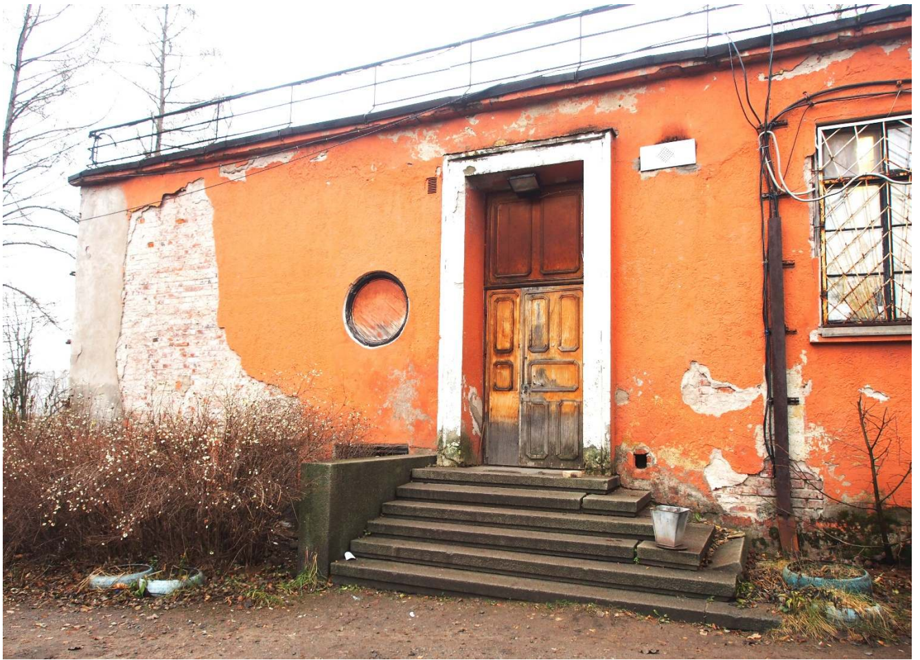
17. Гранитное крыльцо одноэтажной (восточной) части здания.
