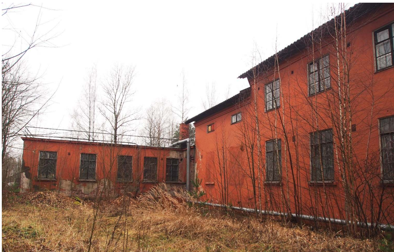
10. Одноэтажная часть здания (западная). Вид с востока.
