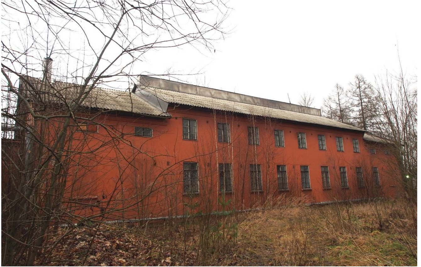
11. Южный фасад. Вид с юго-запада.
