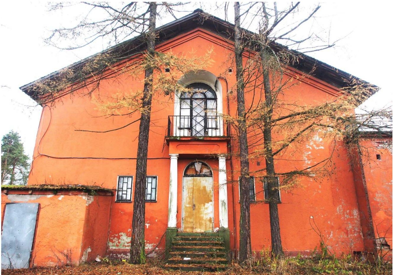
18. Фрагмент восточного фасада. Входная группа. Арочное окно с балконом над входом.
