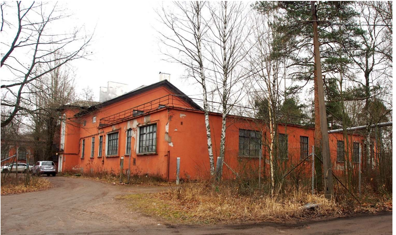
14. Вид здания с запада.
