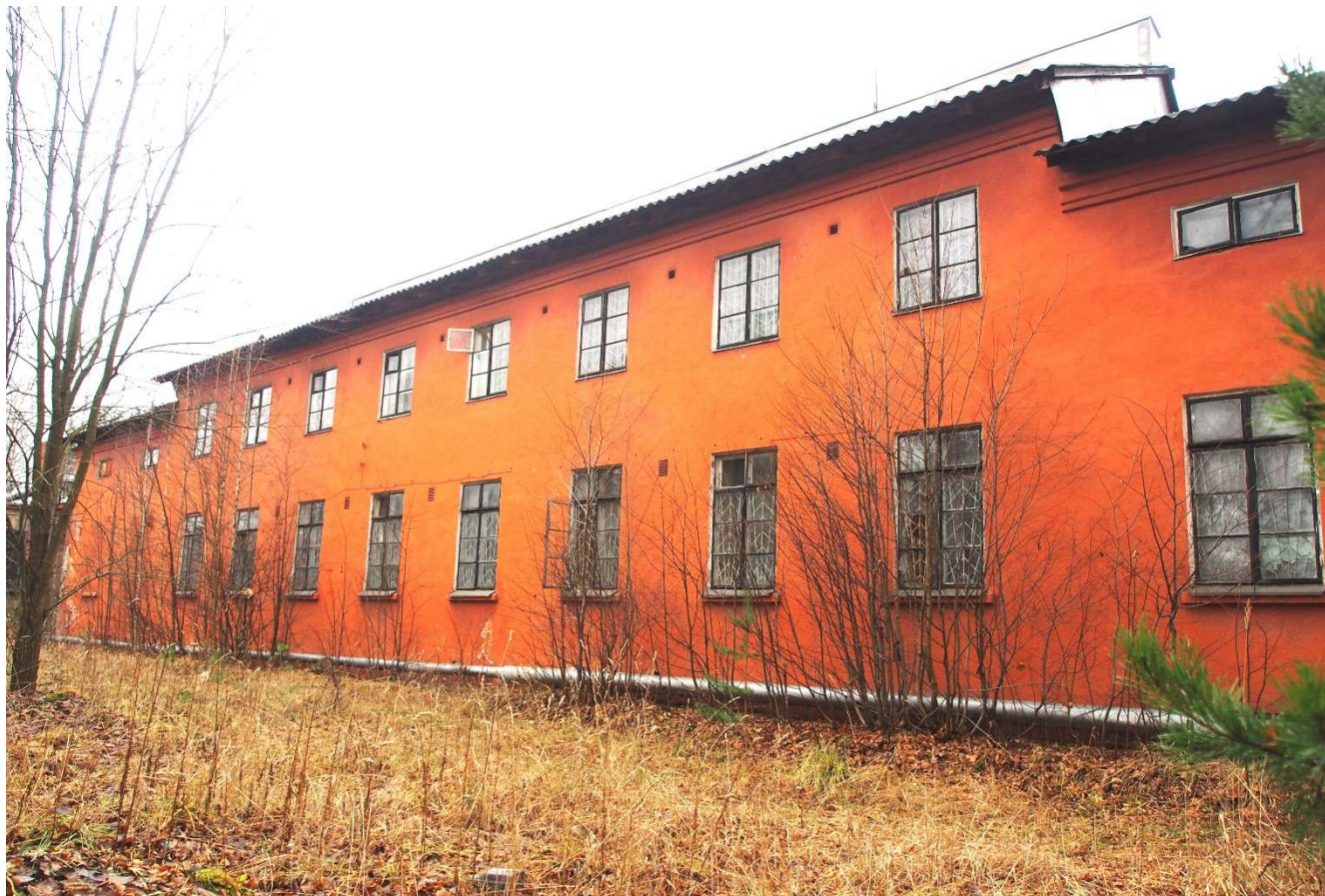
9. Южный фасад. Вид с востока.
