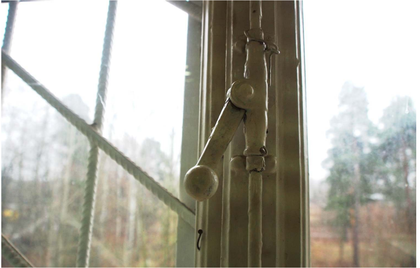
27. Эспаньолет 1930-х гг. окна второго этажа в центральной части здания.
