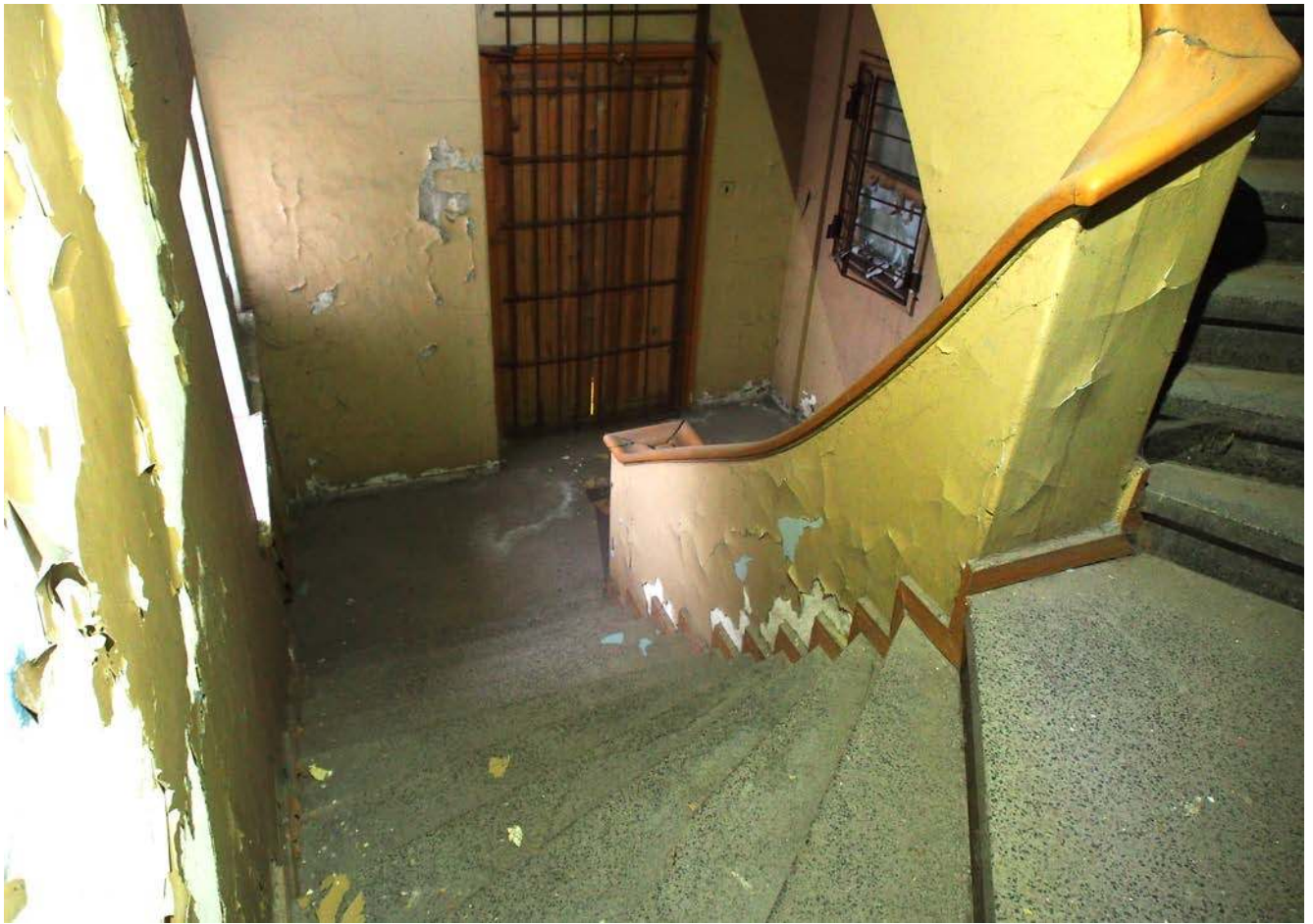
31. Служебная лестница. Бетонные ступени с каменной крошкой.
