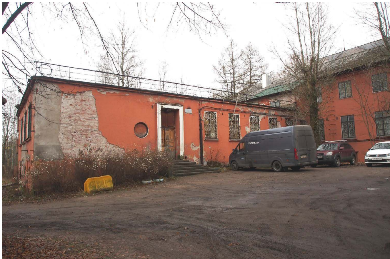
3. Юго-западный фасад одноэтажной части здания (восточной).
