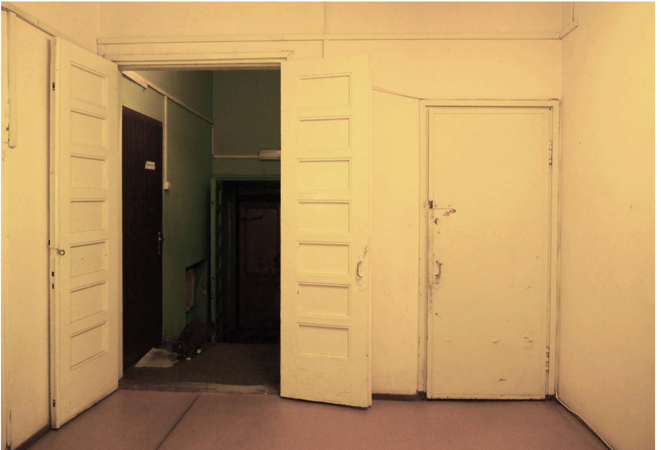
36. Вестибюль западного входа одноэтажной (восточной) части здания. Филенчатые двери.
