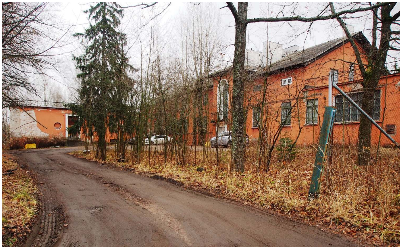
1. Вид здания с запада.
