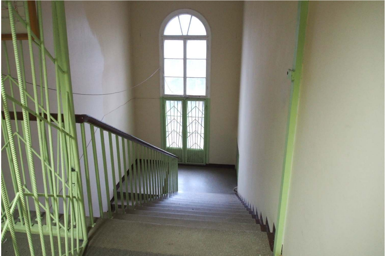
23. Арочное окно на лестничной площадке в центральной части здания.
