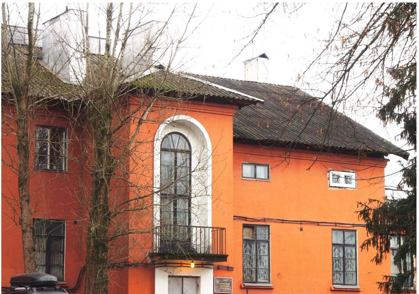
16. Фрагмент северного фасада. Арочное окно с балконом над входом.
