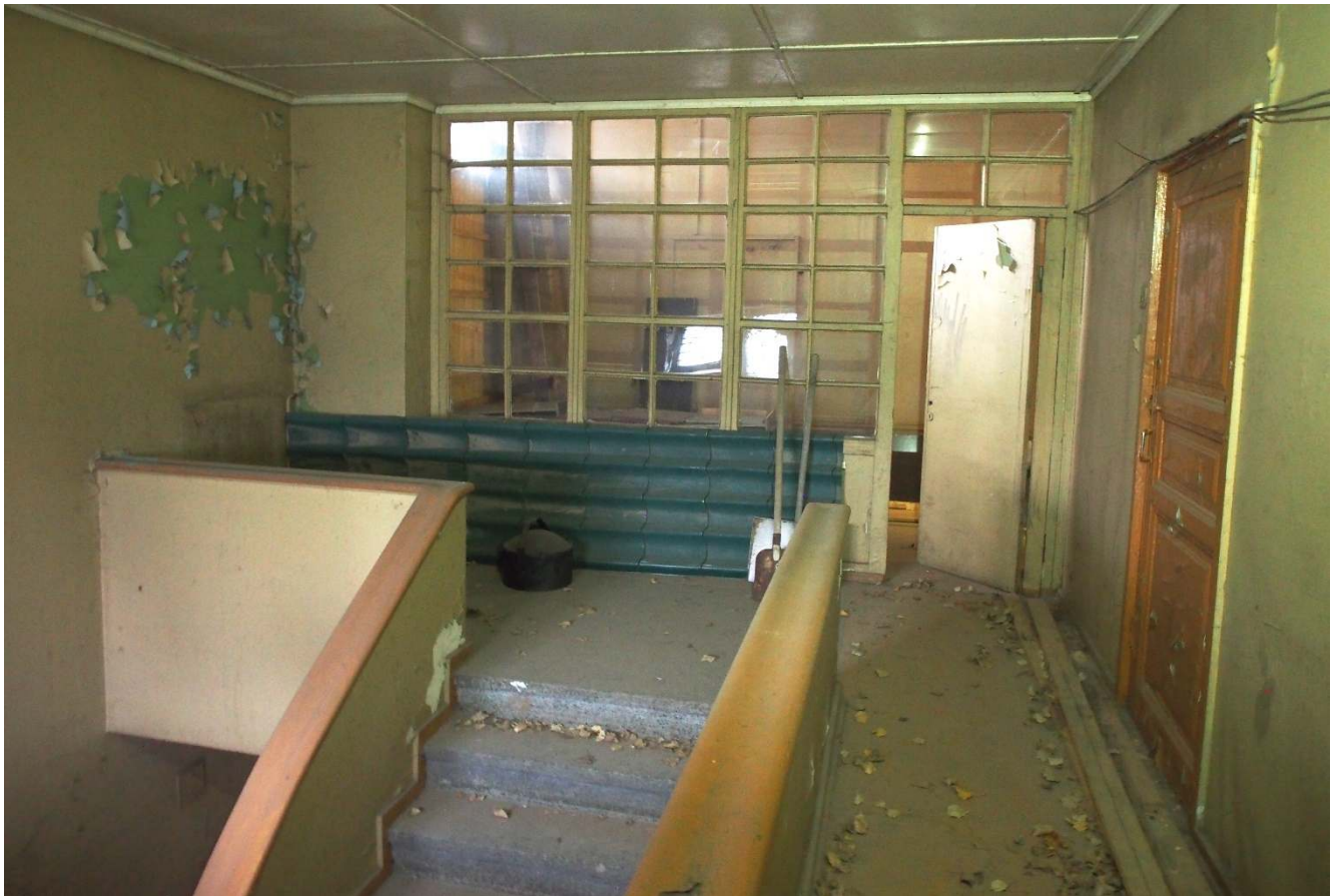
29. Площадка служебной лестницы в восточной части здания.
