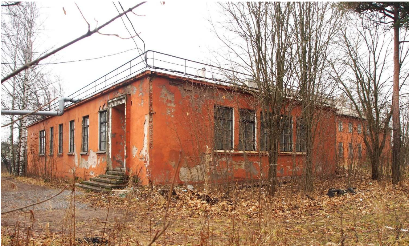
12. Одноэтажная часть здания (западная). Вид с юга.
