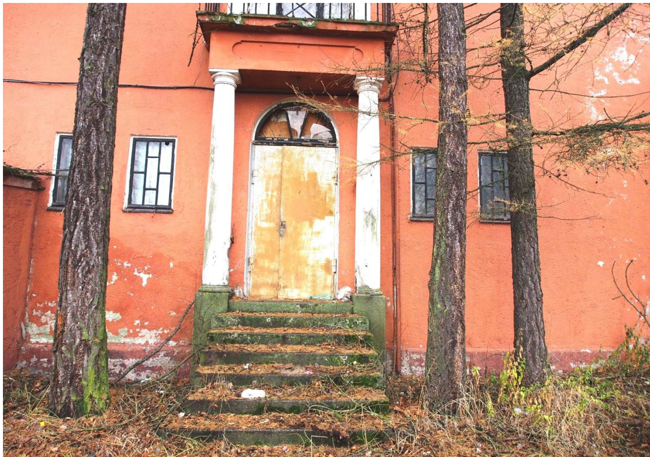
19. Фрагмент восточного фасада. Входная группа. Гранитное крыльцо с бетонными колоннами.
