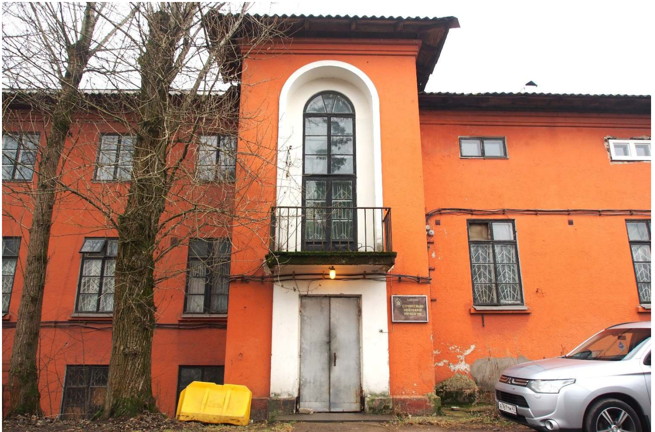
15. Фрагмент северного фасада. Лестничный блок с входной группой.
