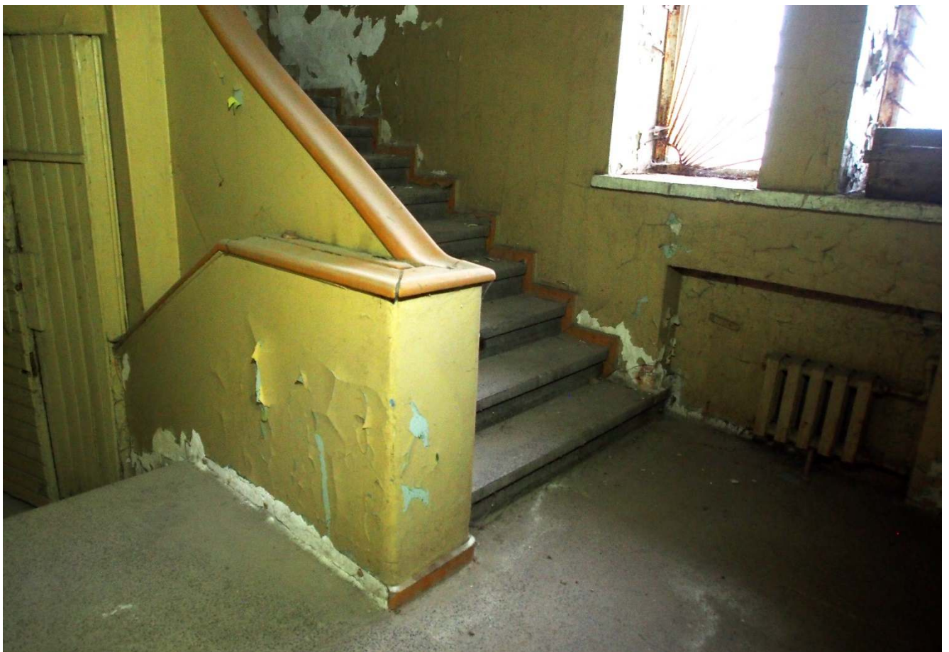
32. Бетонное ограждение служебной лестницы с деревянным поручнем.
