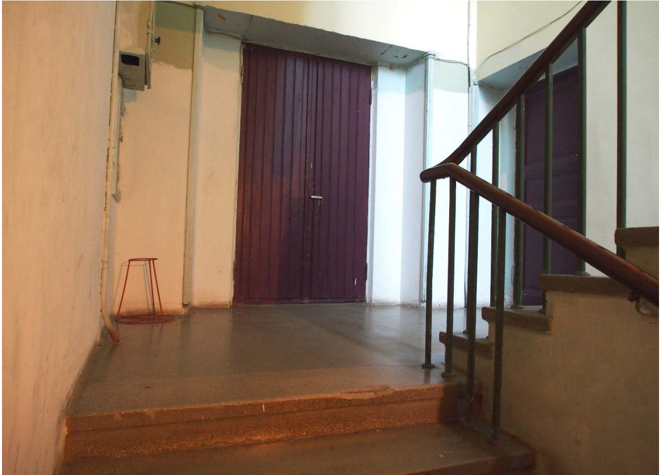
21. Наливной пол вестибюля в центральной части здания. Бетонный с каменной крошкой.
