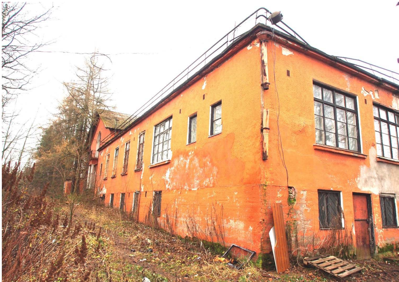
7. Восточный фасад. Вид с северо-востока.
