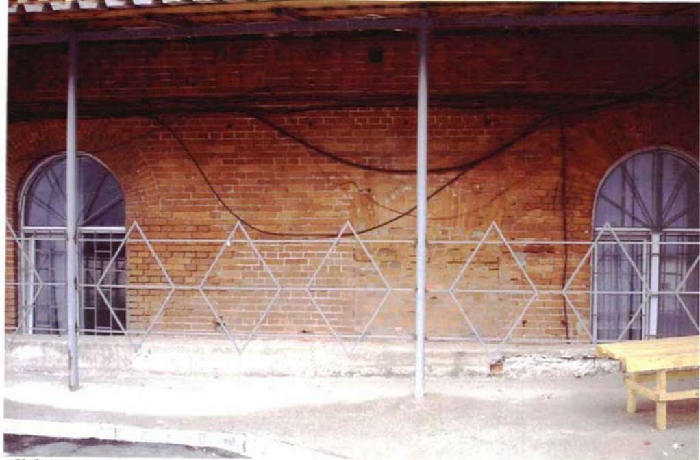
г. Хабаровск, ул. Волочаевская, 146. «Дом доходный Я.А. Смаги», до 1899 г., 1913 г. Северо-восточный фасад, фрагмент средней части.
