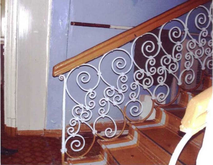
г. Хабаровск, ул. Волочаевская, 146. «Дом доходный Я.А. Смаги», до 1899 г., 1913 г. Ограждение металлической лестницы
