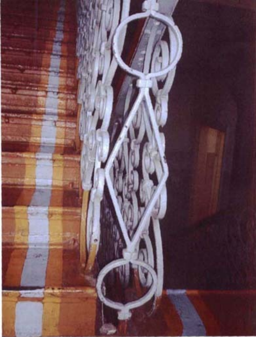
г. Хабаровск, ул. Волочаевская, 146. «Дом доходный Я.А. Смаги», до 1899 г., 1913 г. Соединительный элемент ограждения металлической лестницы Фото Дыминской А.В., 2006 г.
