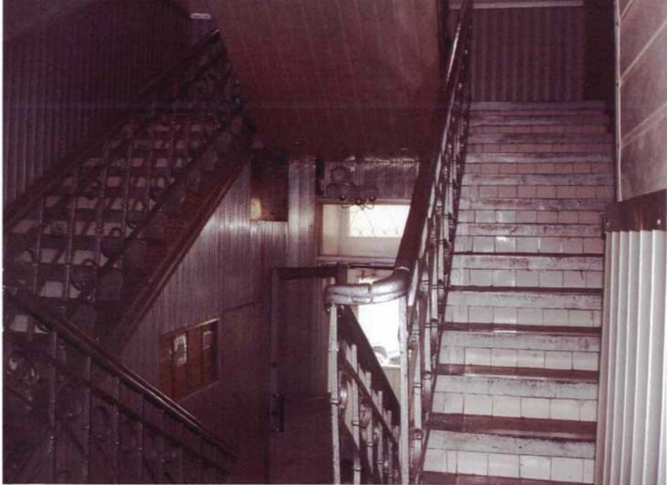
г. Хабаровск, ул. Волочаевская, 146. «Дом доходный Я.А. Смаги», до 1899 г., 1913 г. Интерьер лестницы главного входа
