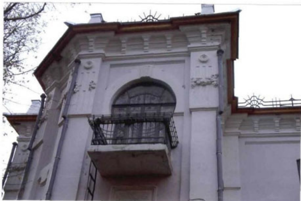
Дом Ф. Ефремова (Дом, в котором работали ЦИК, Облисполком и Совет Министров ЧАССР), 1911 г., Чувашская Республика, г. Чебоксары, ул. К. Иванова, 4
